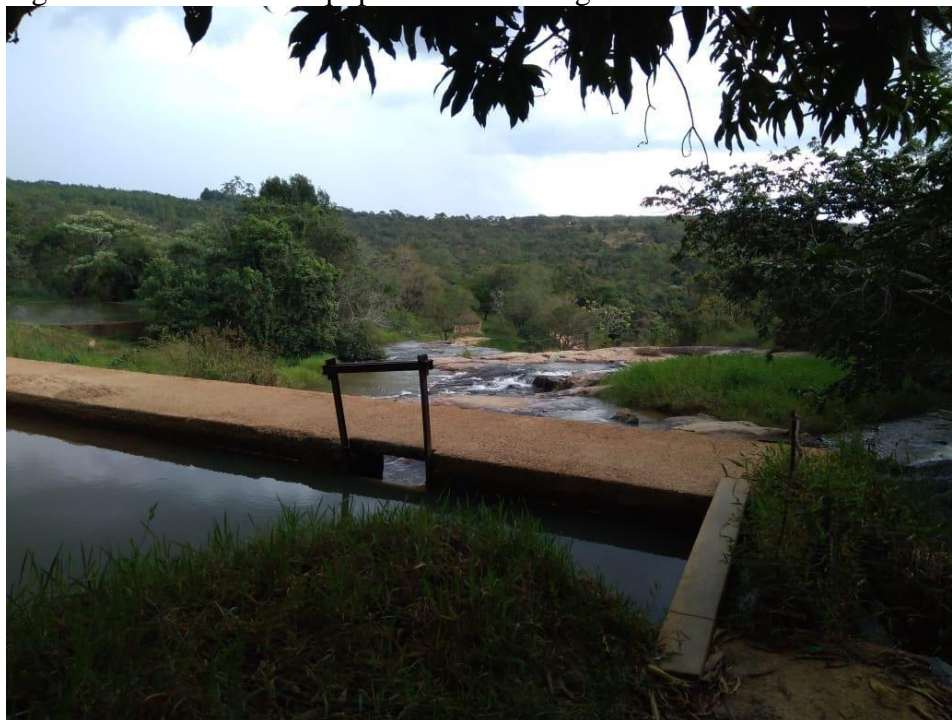
Figura 25 - Estrutura e equipamentos da antiga usina hidrelétrica do PMUV
