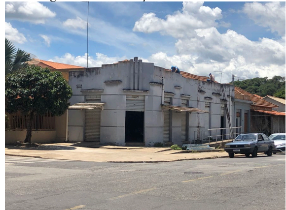
Figura 18 – Edificação de uso comercial
