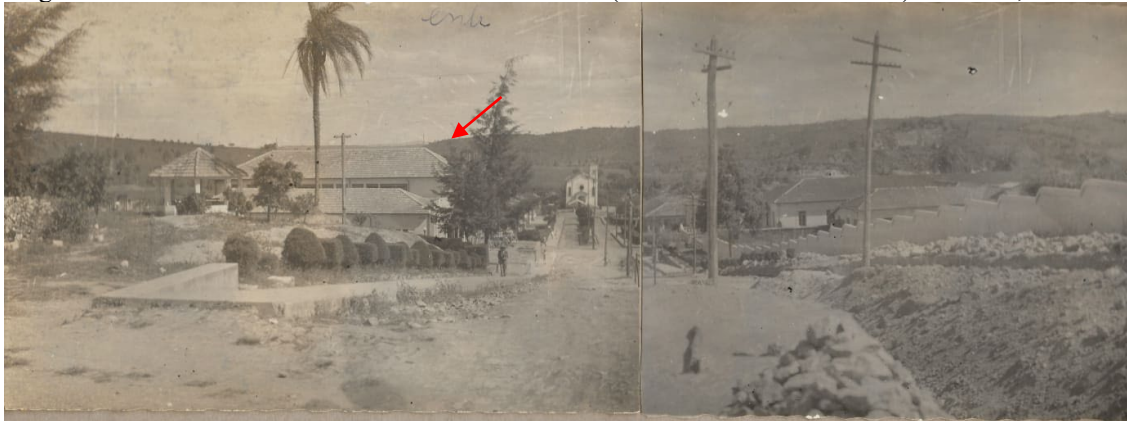
Figura 21 – Vista da Avenida Professor Antônio Aleixo (eixo leste-oeste da colônia) e entorno, sem data
