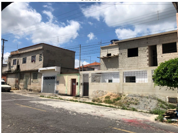
Figura 24 – Ocupação residencial na Rua Abílio de Castro
