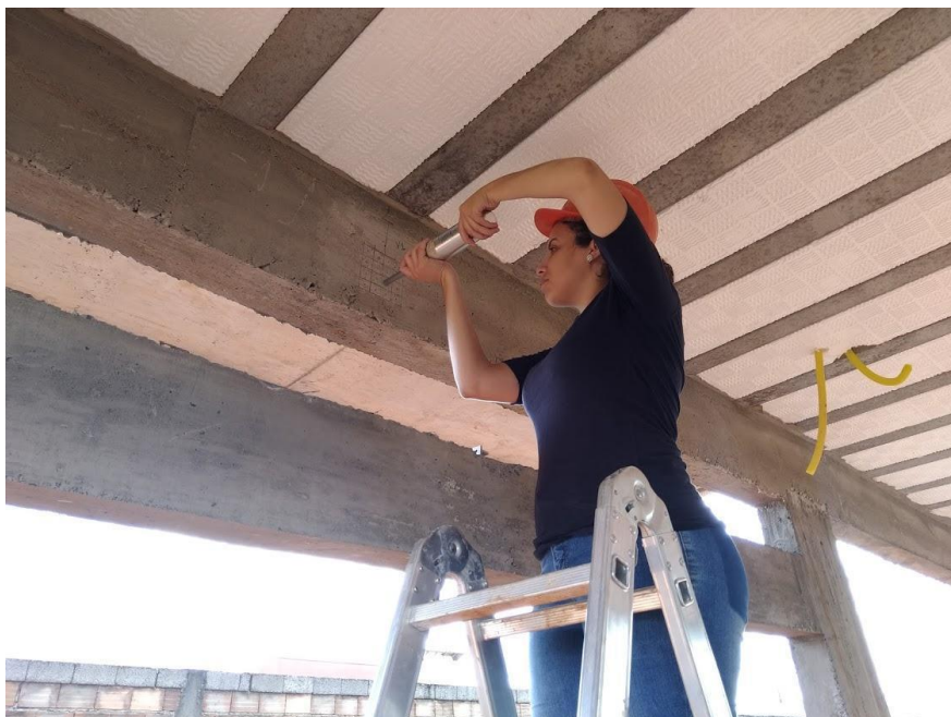
Figura 14 - Realização do ensaio esclerométrico na Viga 1.
