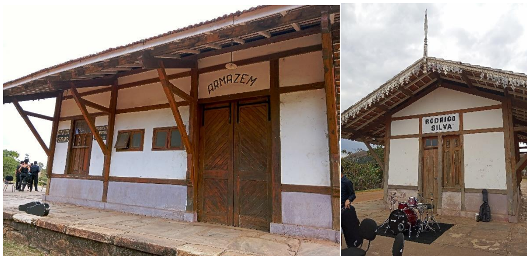
Figure 22 - Detalhes das Fachadas Estação de Rodrigo Silva (portas, janelas e vigas)
