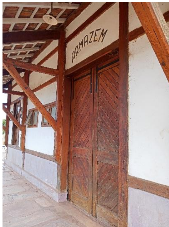
Figure 24 - Porta de acesso ao armazém
