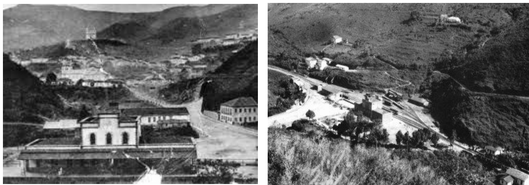
Figure 6 - Início da ocupação do bairro da Estação, em Ouro Preto/MG em 1920
