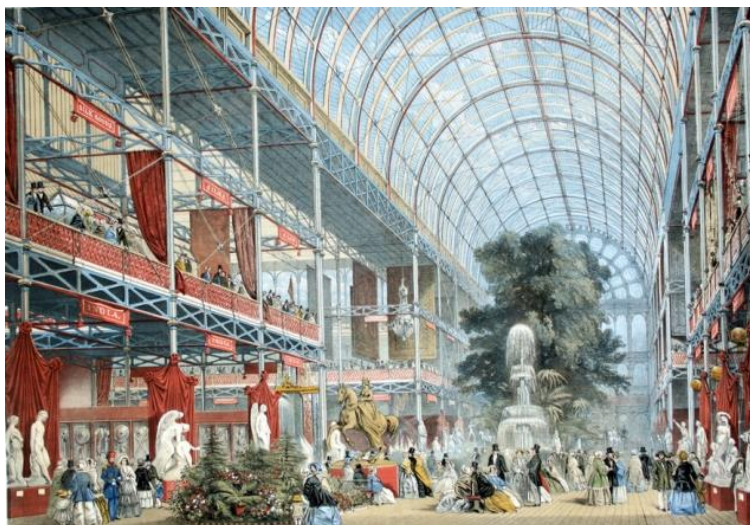
Figure 3 - Construções de ferro e vidro utilizadas nas Exposições Universais. Crystal Palace, utilizado na Exposição Universal de Londres, em 1851.
