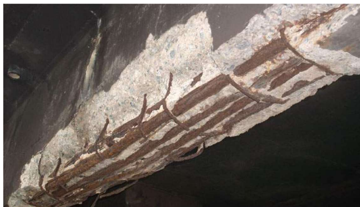
Figura 12: Causas de insuficiência de cobrimento
