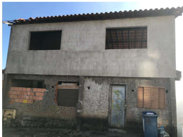
Figura 22: Fachada da residência
