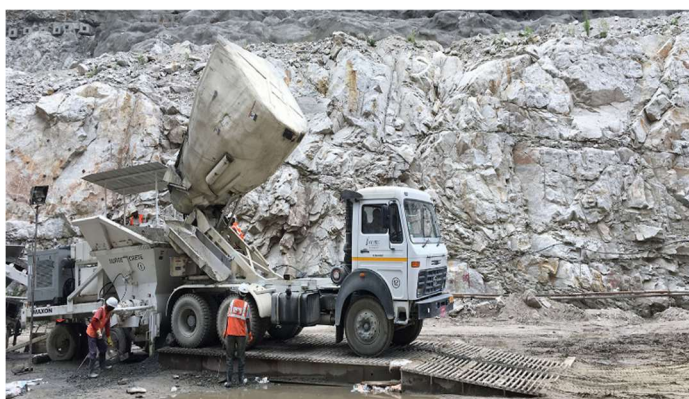
Figura 1: Caminhão basculante do tipo dumpcrete
