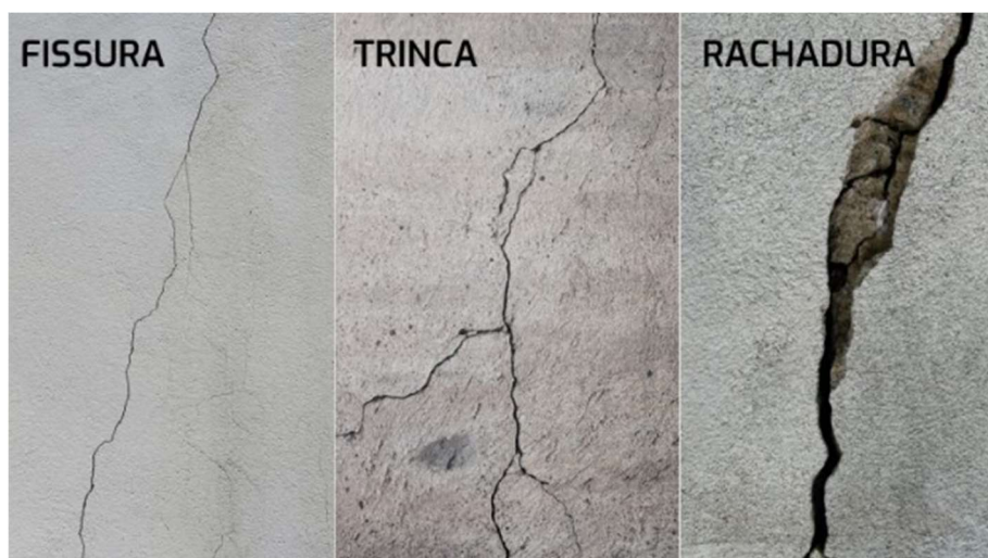
Figura 17: Tipos de fissuras
