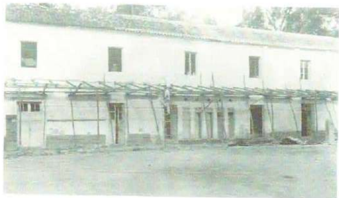
Vista do Pátio interno – 1915
