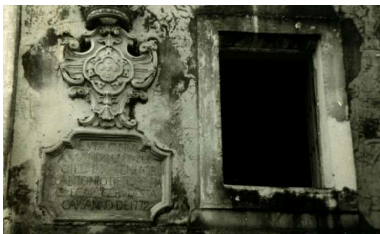
Figura 5 - Placa comemorativa do início da construção do Quartel Dos Dragões Fixada nas paredes do Edifício do Colégio Dom Bosco
