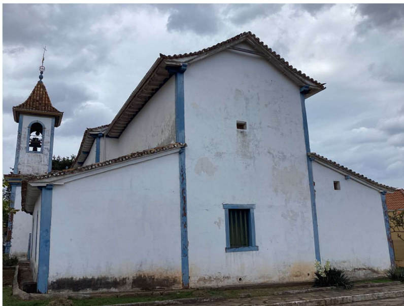
FIGURA 6 – Fachada sudeste. Fonte: Autor: 2024.
