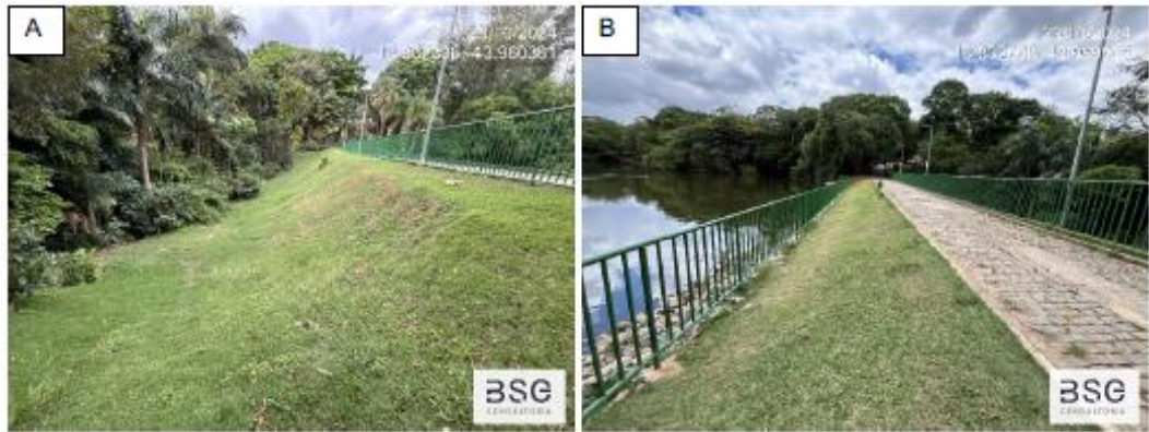
Figura 14 – Vista do talude: (A) jusante; (B) montante
