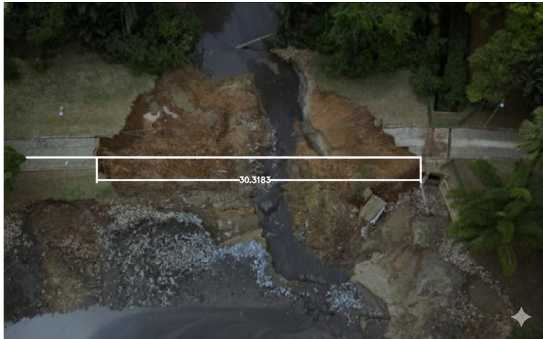
Figura 20 – Medição da brecha real
