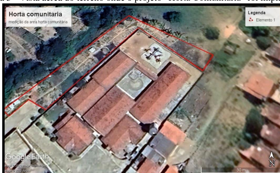
Figura 3 - Vista aérea do terreno onde o projeto “Horta Comunitária” foi implantado.
