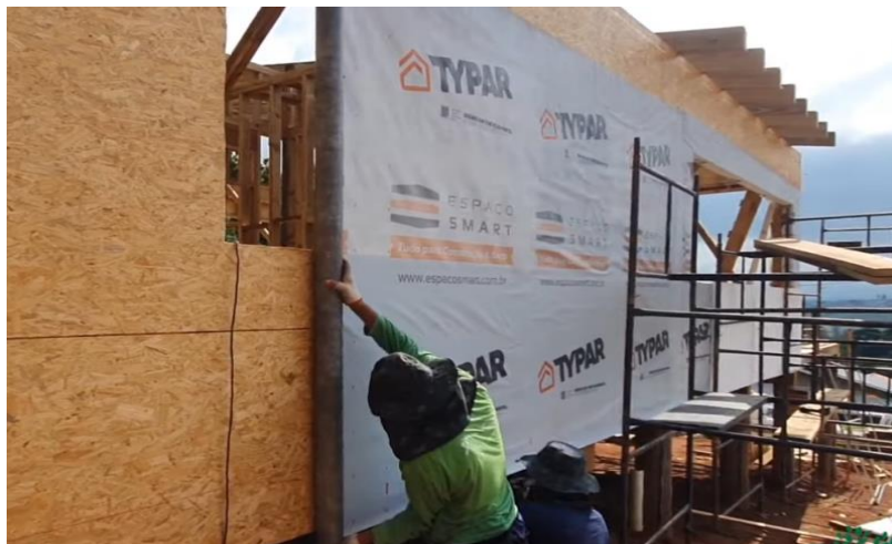
Figura 12 - Colocação membrana hidrófuga.
