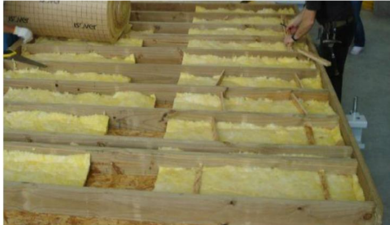
Figura 11 - Isolamento térmico acústico.
