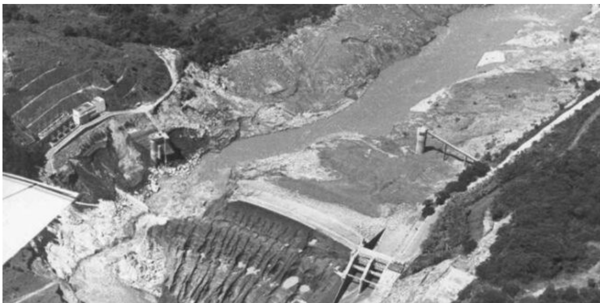
Figura 2 - Rompimento da Barragem Euclides da Cunha em 1977.
