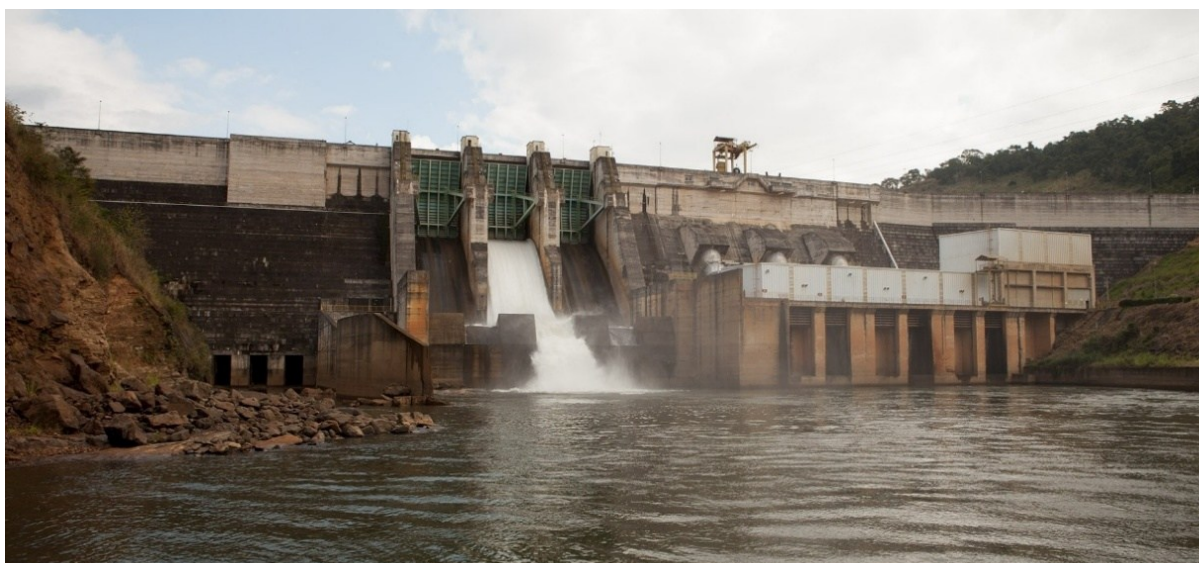
Figura 13 - Vista de jusante da UHE Risoleta Neves antes do reforço estrutural.
