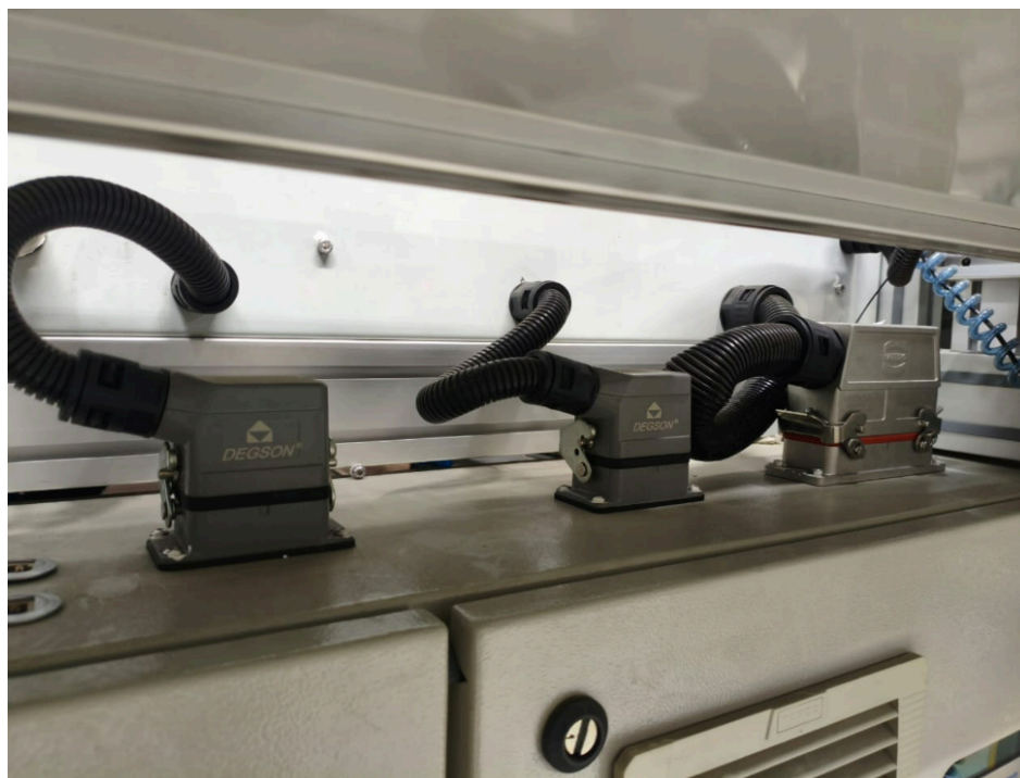
FIGURA 48 - Interfaces das tomadas de conexão da bancada da última linha aplicada a padronização
