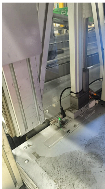
FIGURA 57 - Conjunto de elevação da segunda linha aplicada a padronização, motor com sensor para referenciamento do encoder
