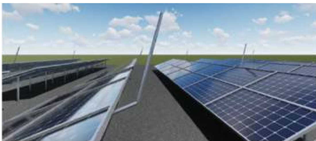
Figura 7 - Uso de mini captosres nos módulos para proteção contra descargas.
