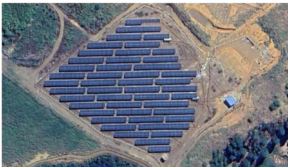
Figura 14 - Vista Superior da Usina Fotovoltaica.
