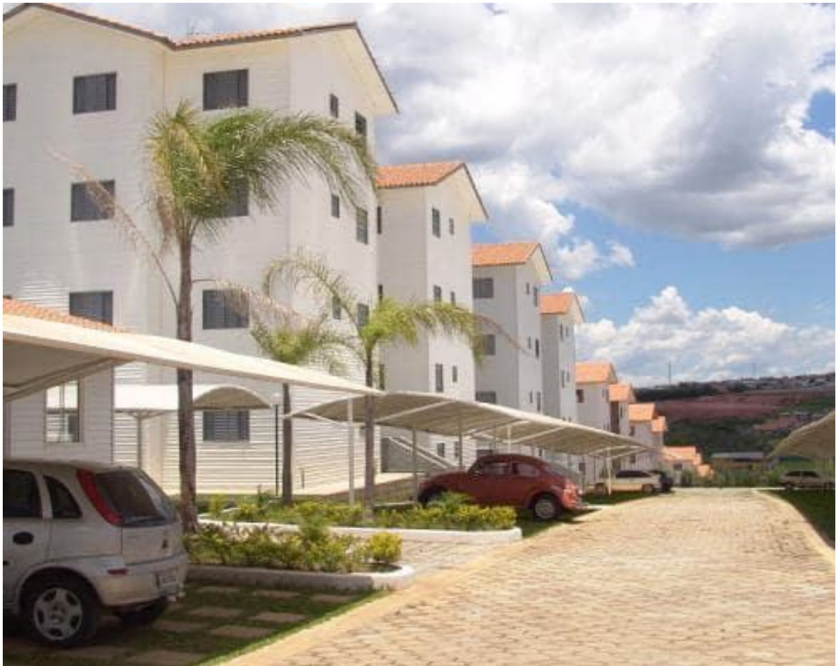
Figura 20: Conjunto habitacional Colina das Pedras finalizado
