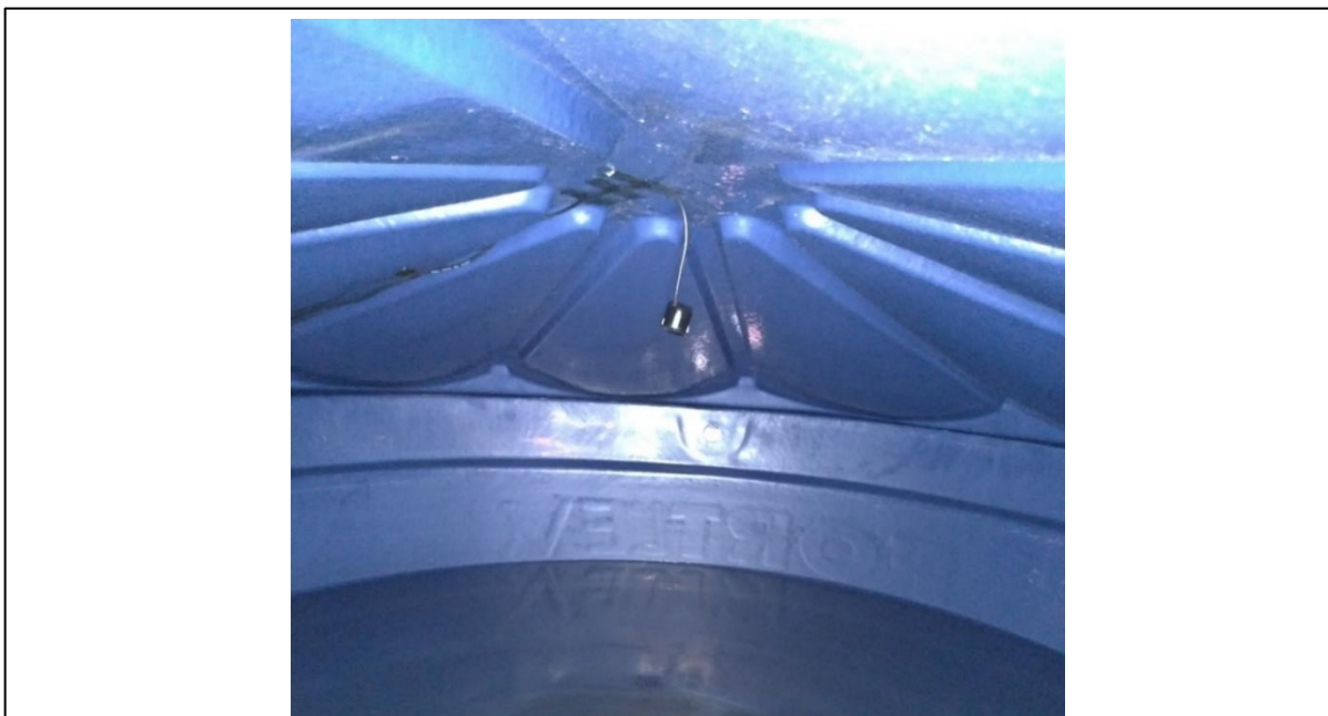
Figura 18 - Instalação do sensor ultrassônico na caixa d'água
