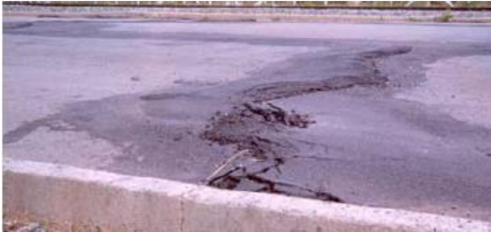
Figura 4 - Pavimento com a utilização de escória não curada (expandida)
