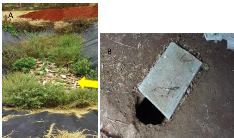
Figura 64: A) Resíduos sem recobrimento e mau estado de conservação da lona impermeabilizante. B) Boca de visita do fosso danificada
