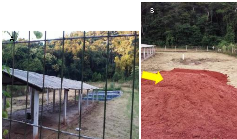
Figura 19: A) Fossos e valas ao fundo. B) Material inerte (terra) para recobrimento.
