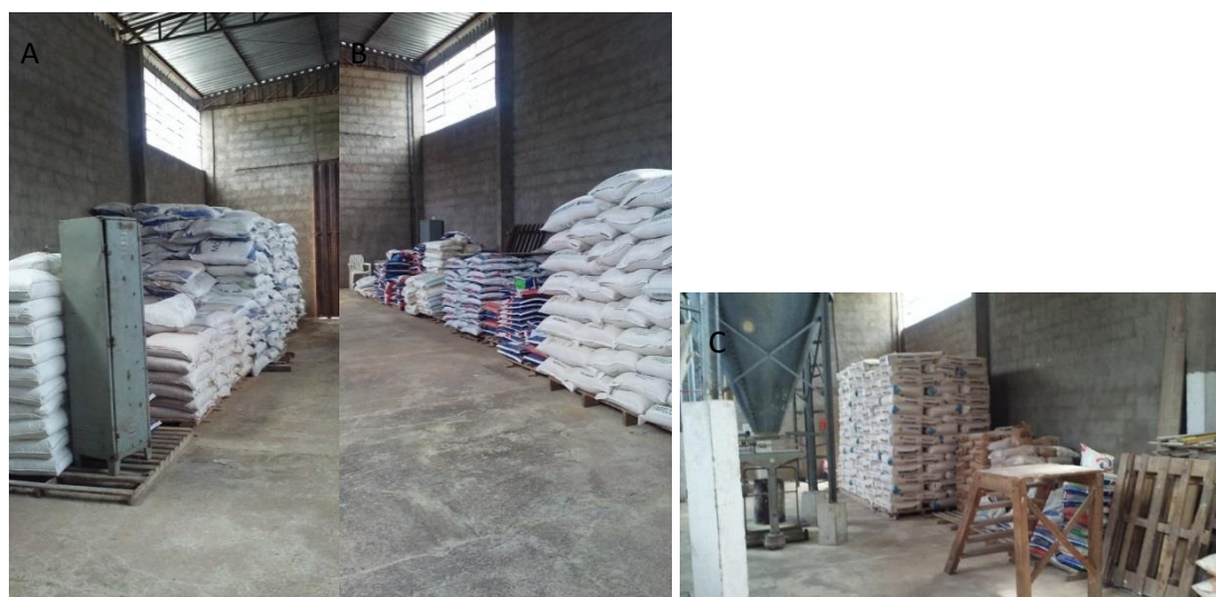
Figura 66: A), B) e C) Boa higiene e organização do galpão de armazenamento da fábrica de rações do IFMG-SJE.
