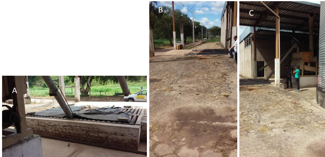
Figura 67: A) Baía para descarregamento da matéria prima B) Drenagem no piso superior C) Piso em cota inferior
