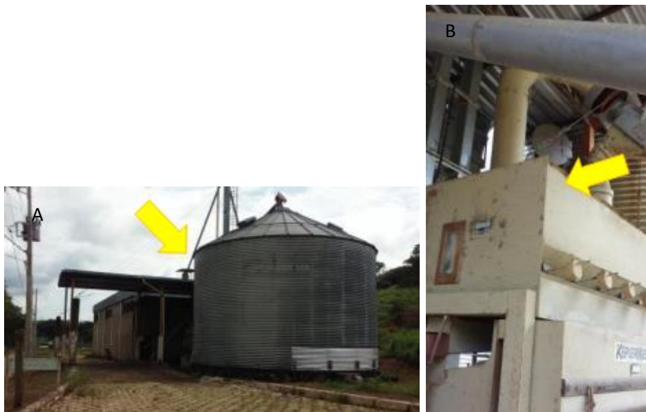
Figura 27: A) Vista geral da fábrica de rações – destaque silo. B) Moedor/ Triturador.
