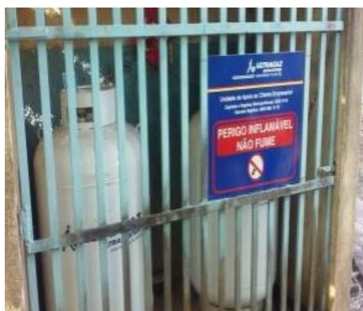
Figura 59: Local de armazenamento das botijas de gás.
