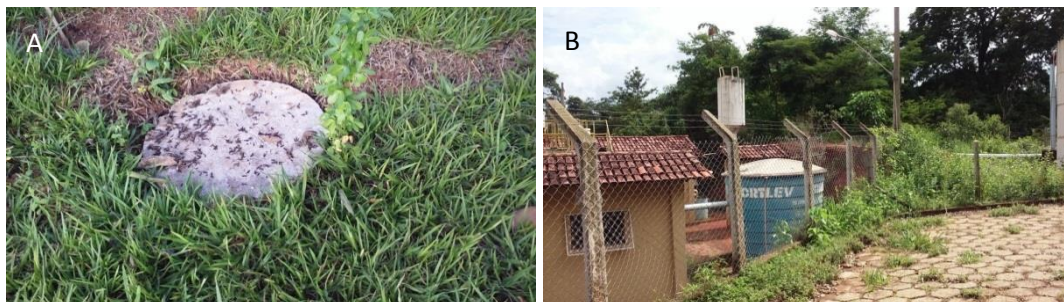
Figura 54: A) ETE e B) ETA.
