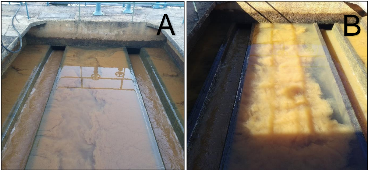
Figura 3 - Fase inicial (A) e final (B) do processo de limpeza dos filtros.
