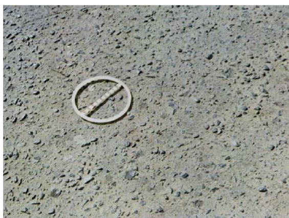
Figura 9 - Desgaste
