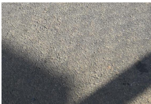
b) Desgaste – Estaca 21
