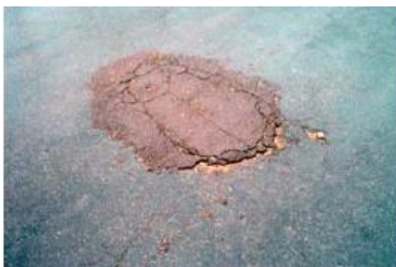
Figura 11 - Remendo
