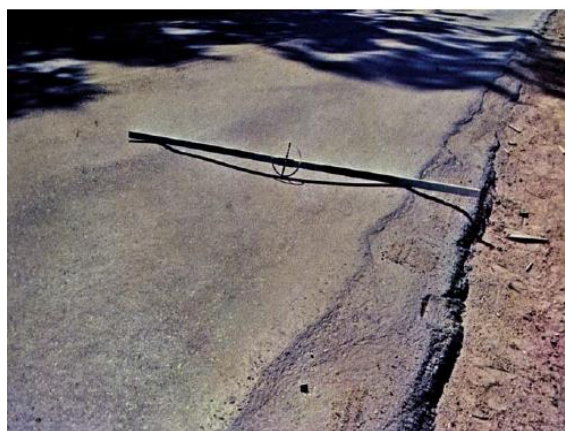
Figura 5 - Afundamento
