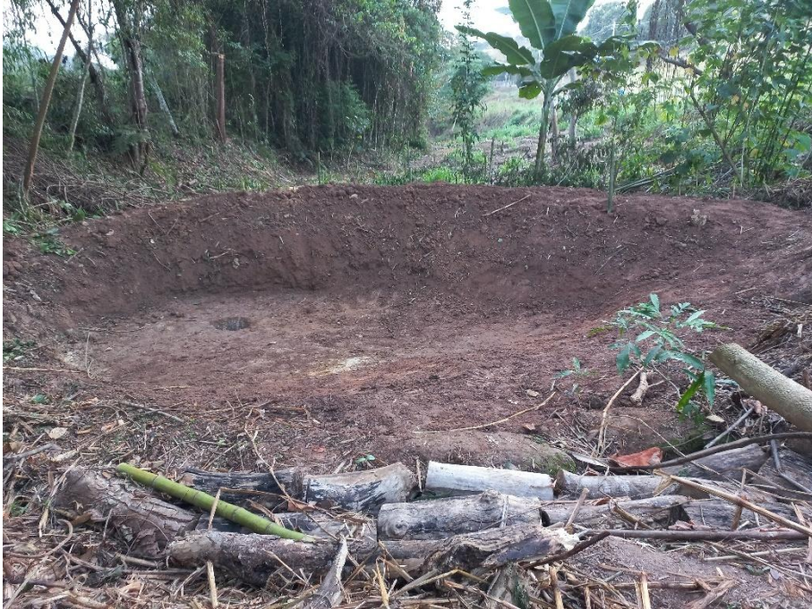
Figura 14. Construção da caixa de contenção de água (barraginha).
