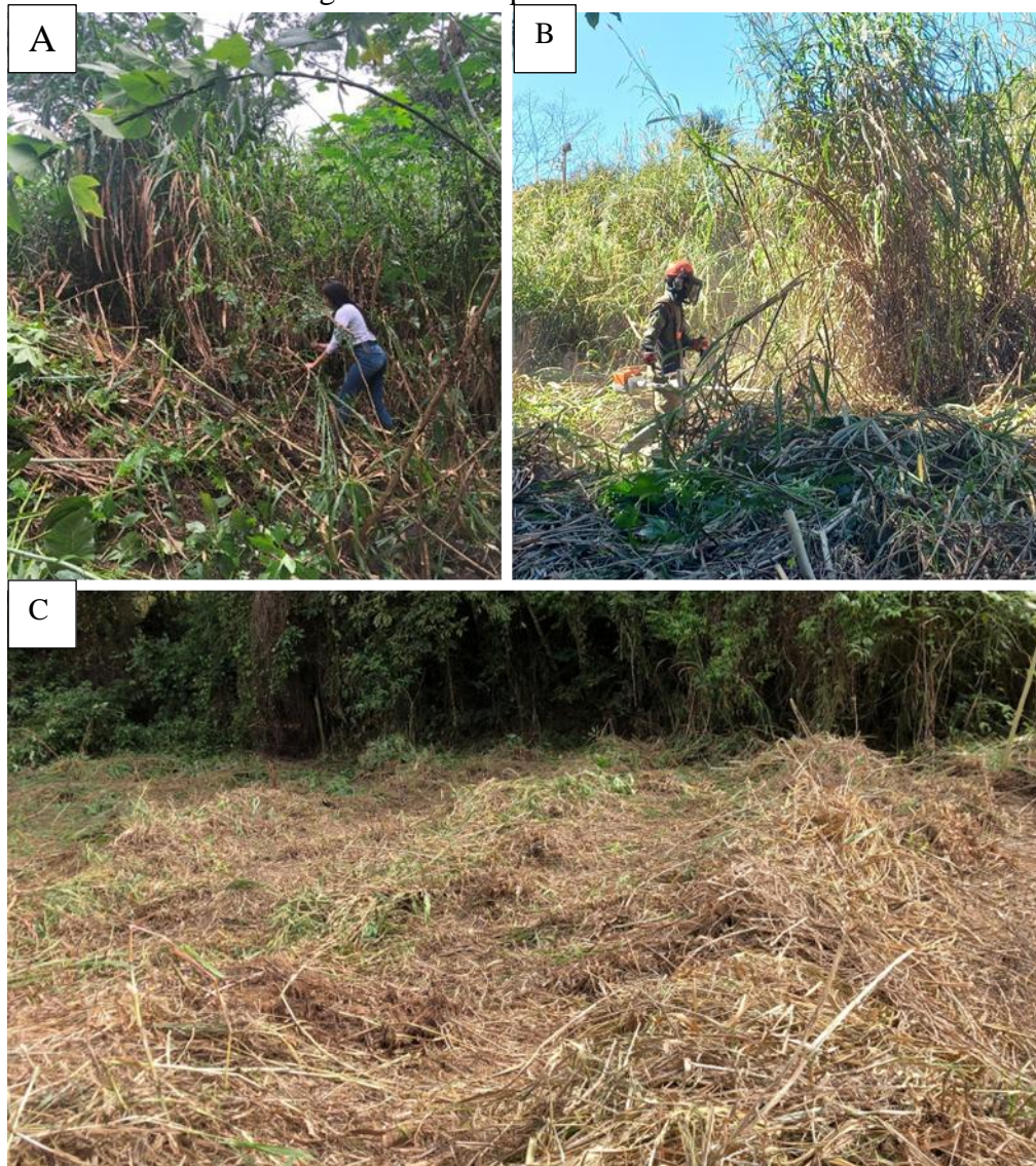
Figura 5. Limpeza inicial da área por meio de roçada manual e semi-mecanizada, e aspecto geral da área após as atividades
