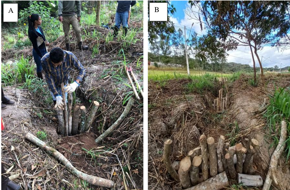
Figura 11. Construção de paliçadas no controle de erosão do solo
