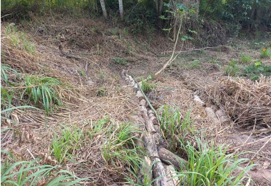
Figura 10. Utilização de toretes de madeira para preencher sulcos de erosão.
