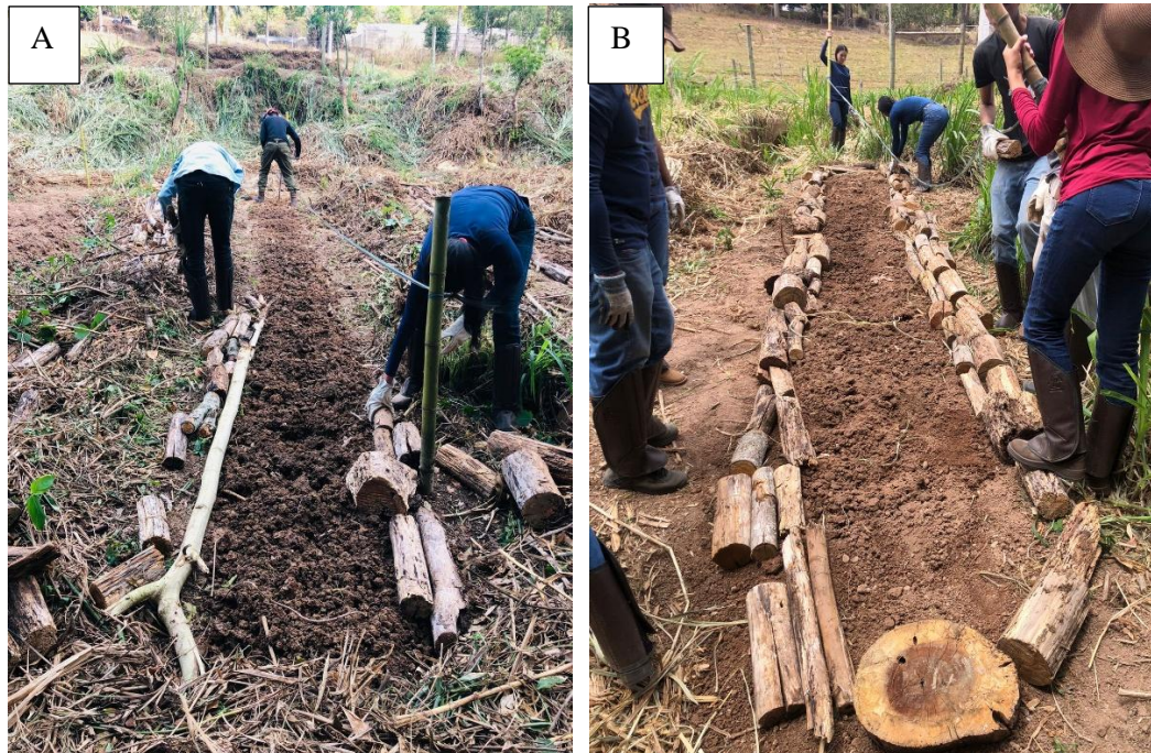
Figura 17. Organização de material lenhoso nas bordas dos canteiros reforçando seu formato côncavo (mais fundo no centro e mais alto nas bordas)
