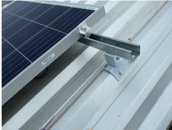
Figura 14 – Fixação em telhado trapezoidal.
