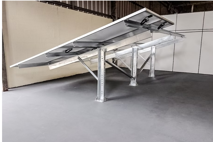
Figura 16 – Fixação feita com bases metálicas.
