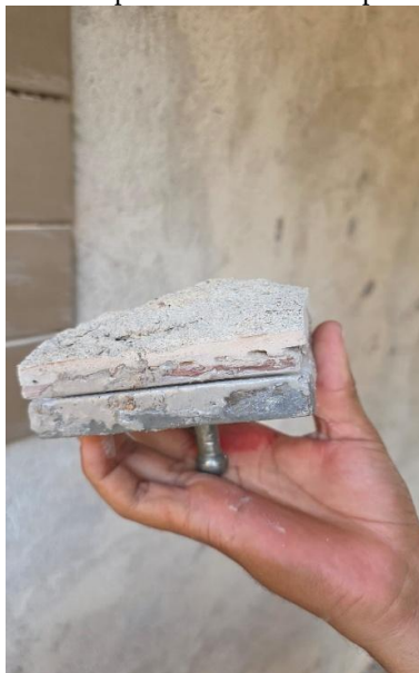
Figura 12 - Corpo de prova CP2 do painel normatizado após ensaio de aderência à tração
