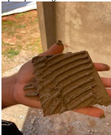
Figura 7 - Aplicação de argamassa no tardo de pastilha
