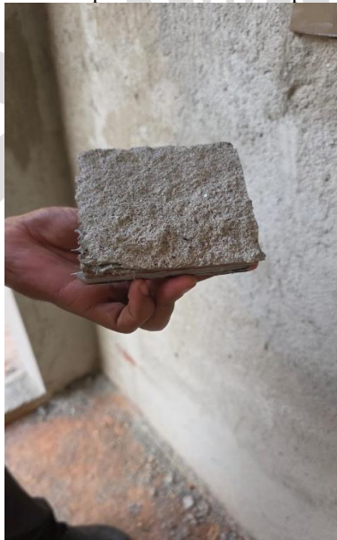
Figura 13 - Corpo de prova CP3 do painel normatizado após ensaio de aderência à tração
