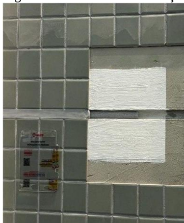
Figura 3 - Juntas de movimentação
