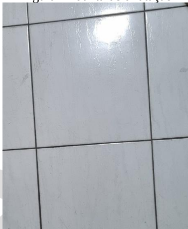
Figura 2 - Junta de dilatação
