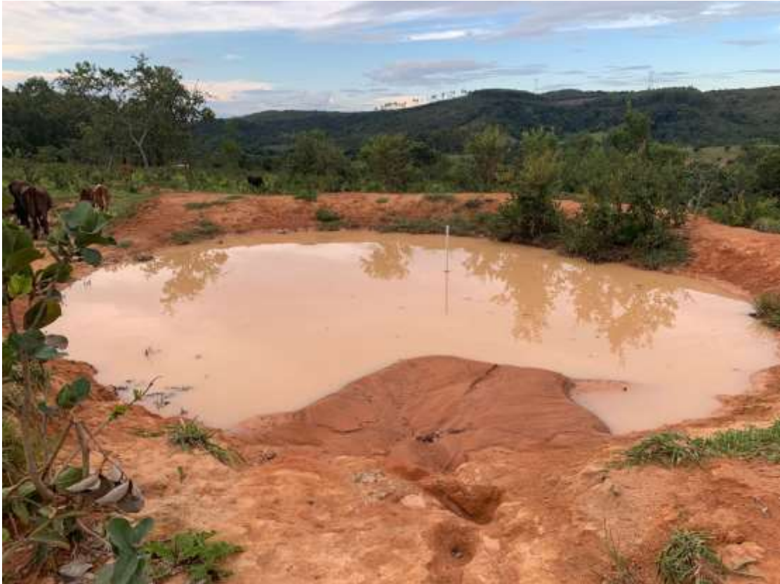
Figura 1- Bacia de retenção na área de estudo na área de estrada.
