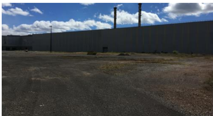
Figura 24. Pátio externo da Área 1 após retirada das sucatas.
