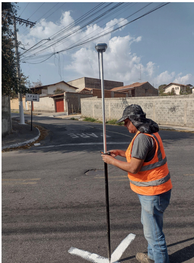
Figura 52: Captação do Ponto de Controle
