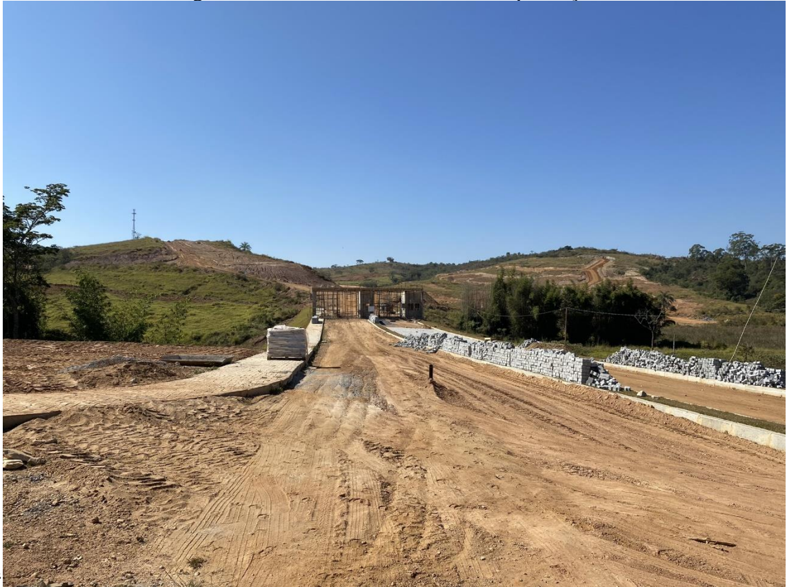
Figura 11 – Loteamento em fase de implantação.
