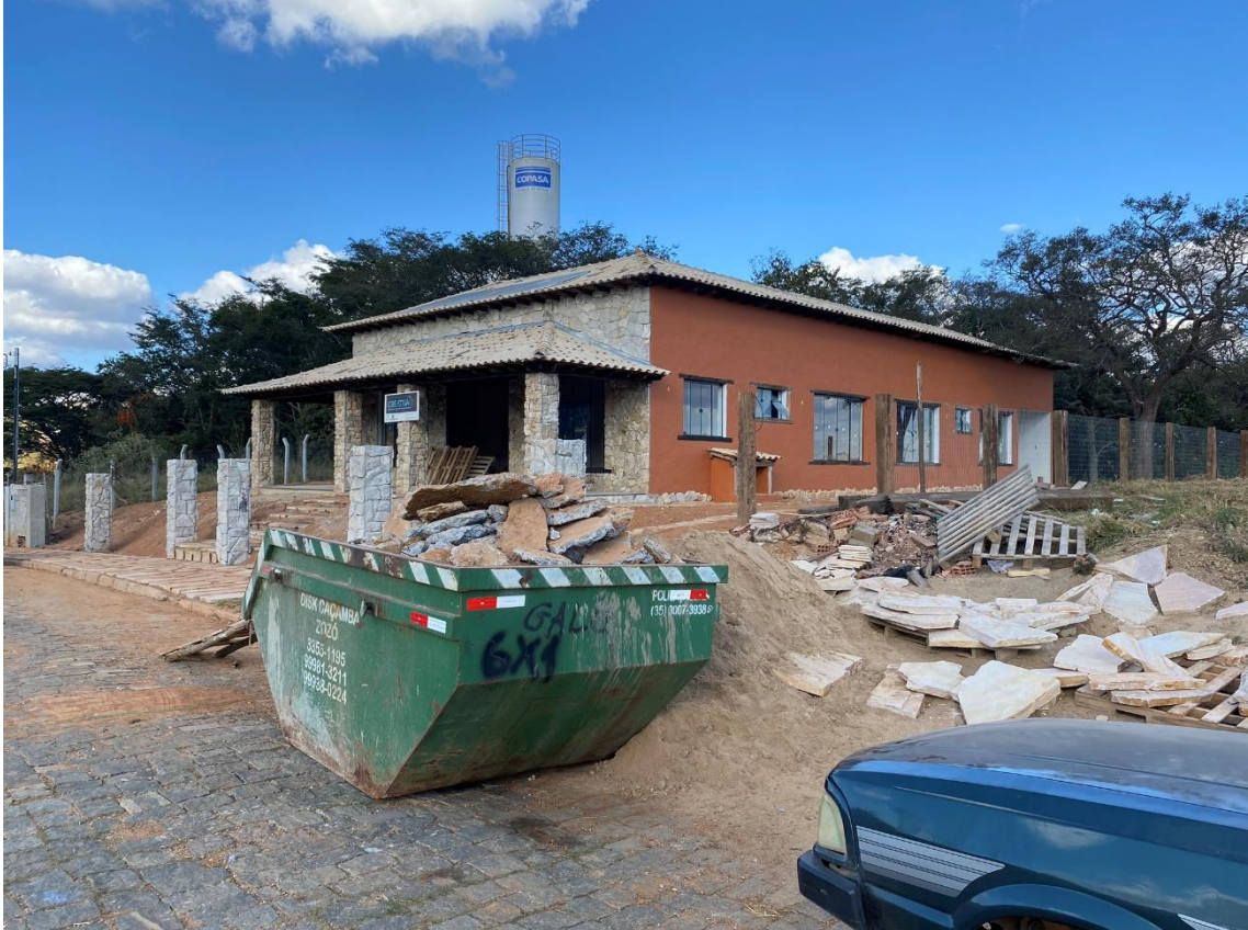
Figura 05 – Edificação em construção, implantada da parte mais alta do Loteamento 01.
