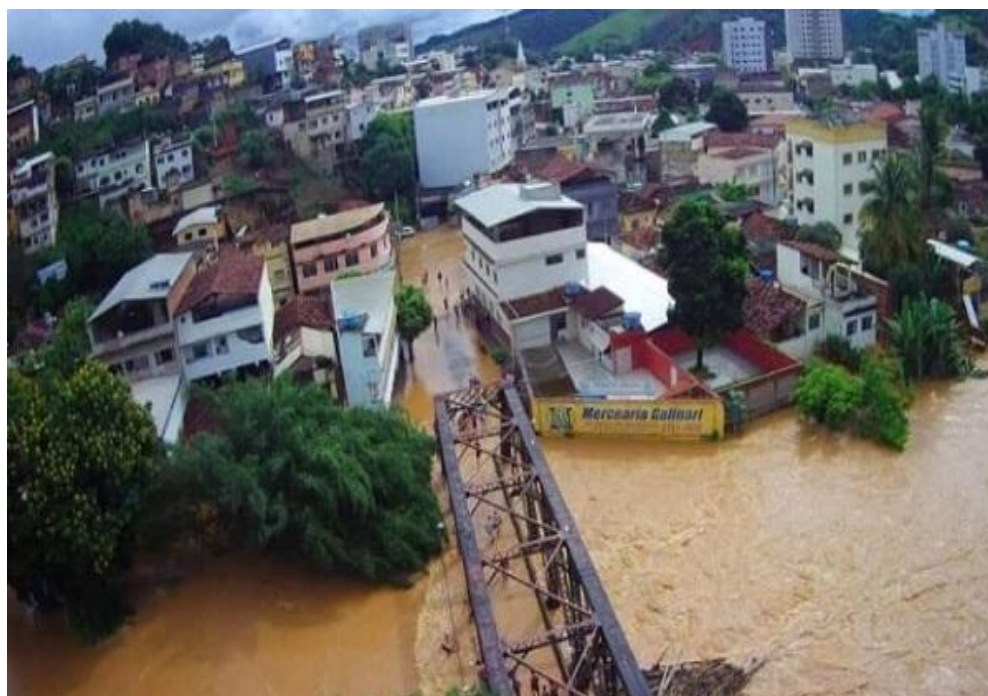
Figura 14 - Inundação em Raul Soares em 2020.
