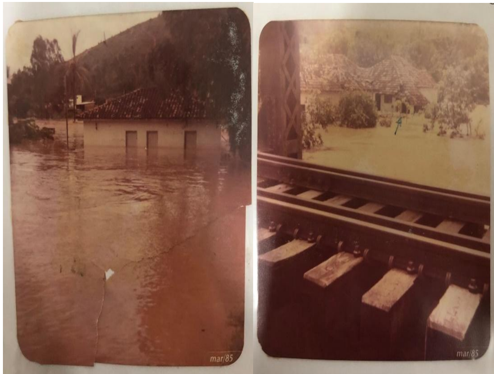
Figura 9 – Inundação em Raul Soares em 1985.
