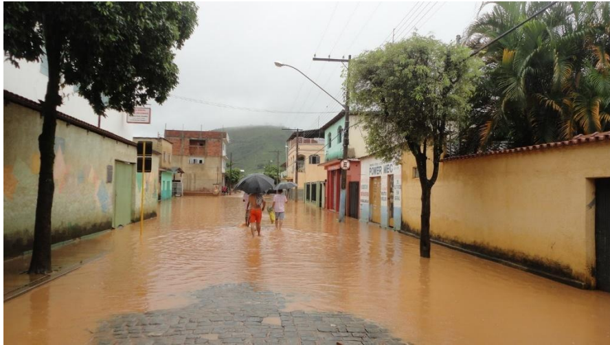
Figura 13 - Inundação em Raul Soares em 2012.
