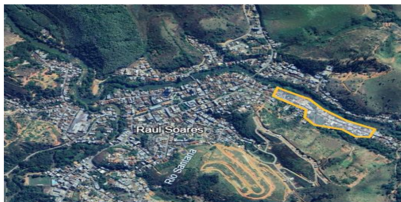
Figura 18 – Delimitação de área frequentemente atingida por inundações.
