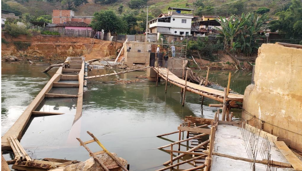
Figura 15 - Reconstrução da ponte sobre o Rio Matipó.
