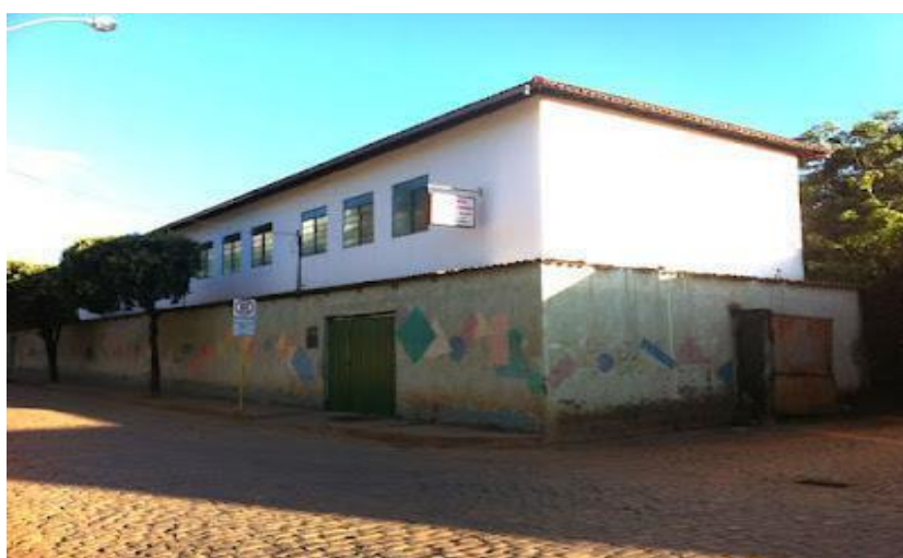
Figura 4 – Prédio atual da EMCJD.
