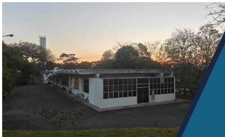
Figura 26 - Centro de Células a Combustível e Hidrogênio do IPEN
