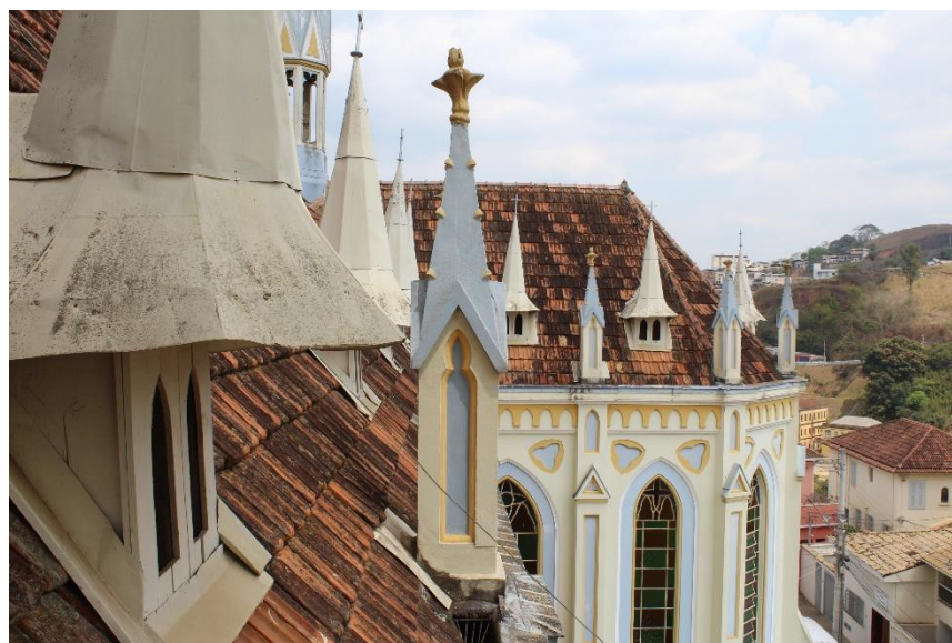
Figura 27 - Pináculo ornamentado com florões e cogulos Matriz São Sebastião – Ponte Nova 2021.
