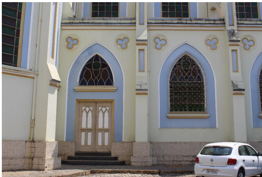
Figura 24 - Matriz São Sebastião - Ponte Nova, fachada lateral esquerda.
