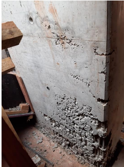
Figura 9 – Nicho de concretagem
