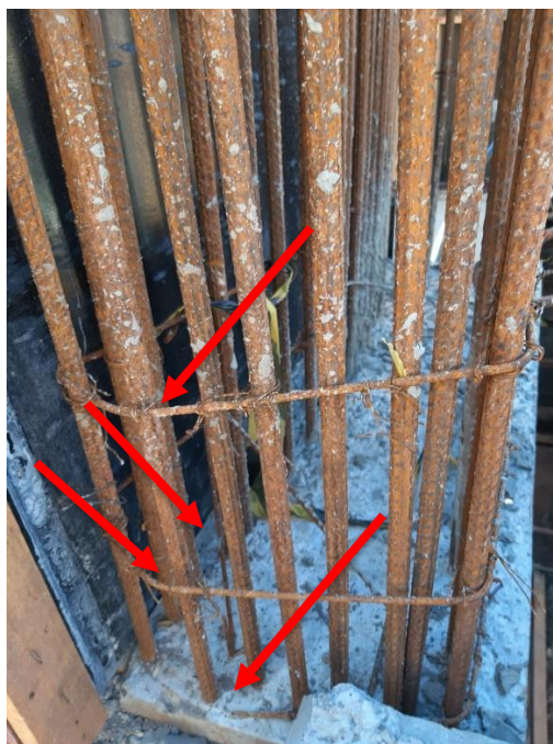
Figura 27 – Envergamento da armadura
