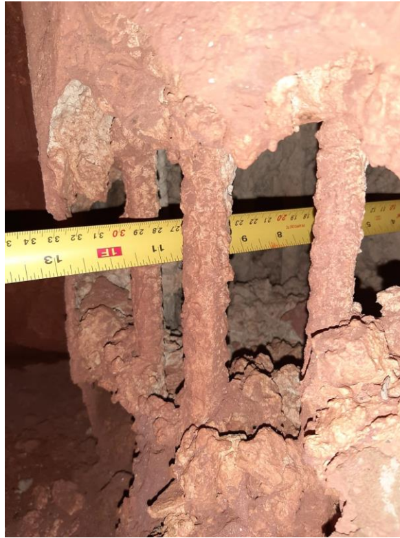
Figura 22 – Estaca 3: vazio em seu interior
