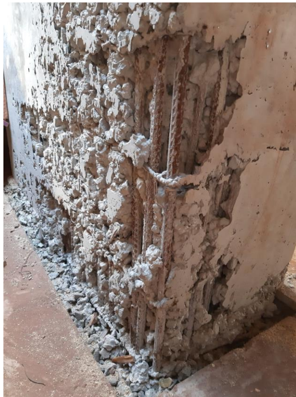
Figura 26 – Detalhamento do “ninho” de concretagem
