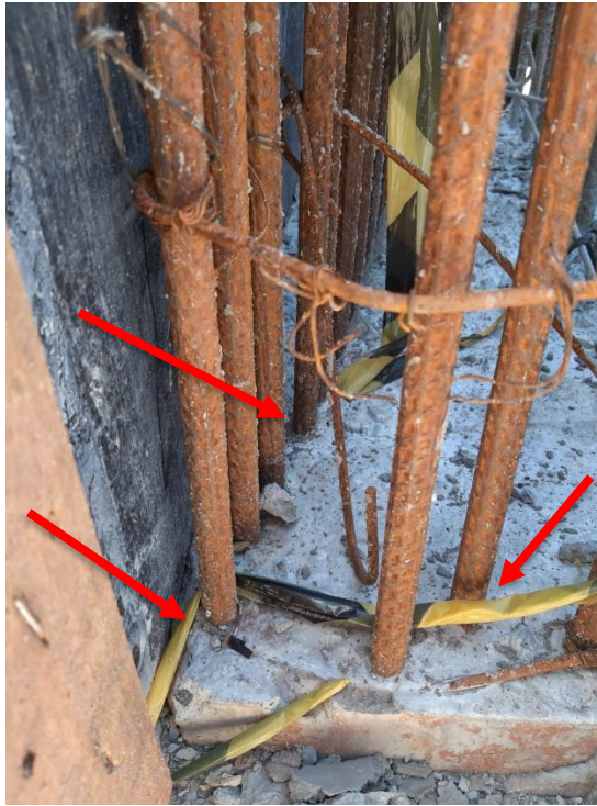
Figura 28 – Envergamento da armadura
