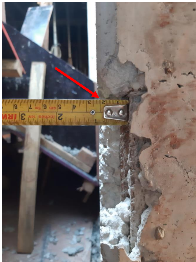
Figura 29 – Medida do cobrimento
