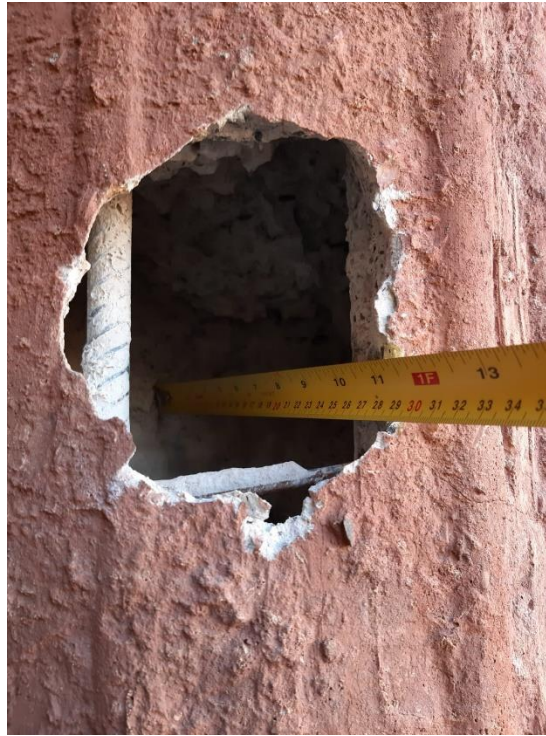
Figura 18 – Estaca 1: vazio em seu interior
