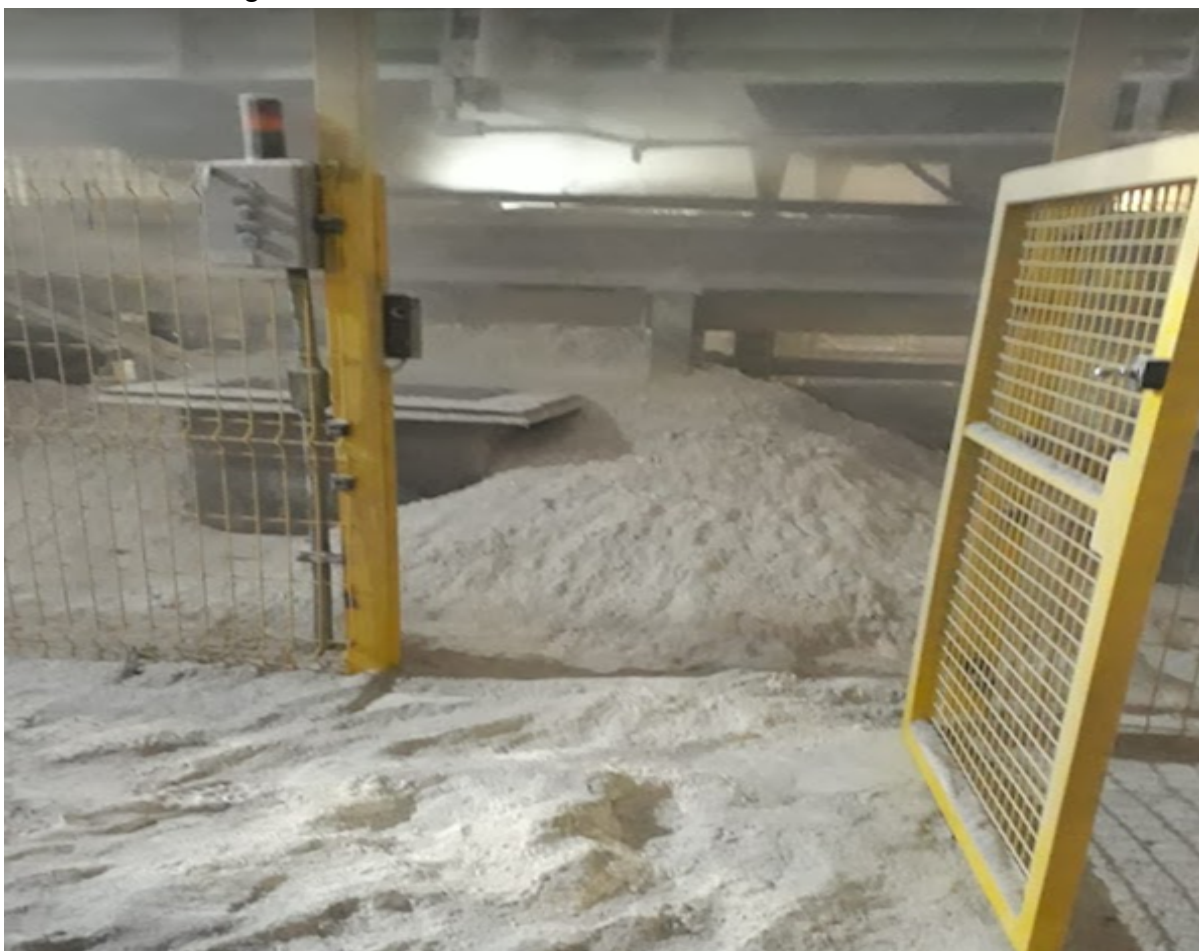
Figura 1 - Transbordamento de material no silo interno.
