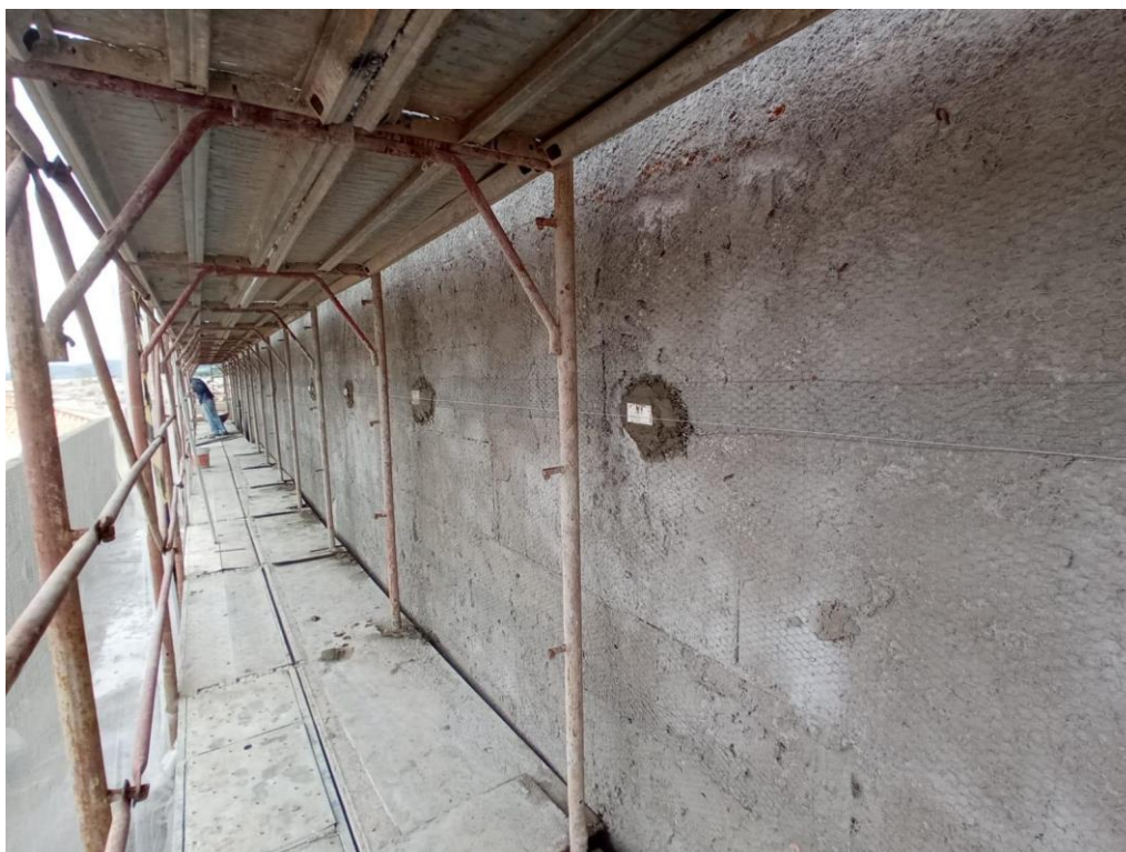
Figura 4 - Execução das taliscas
