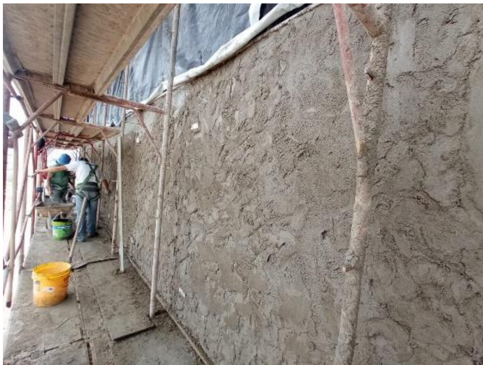
Figura 8 - Execução de emboço para realização de reboco.
