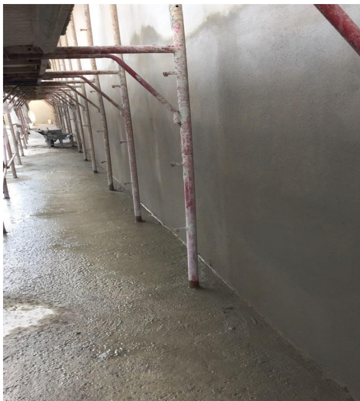
Figura 20 - Finalização do reboco no primeiro pano.
