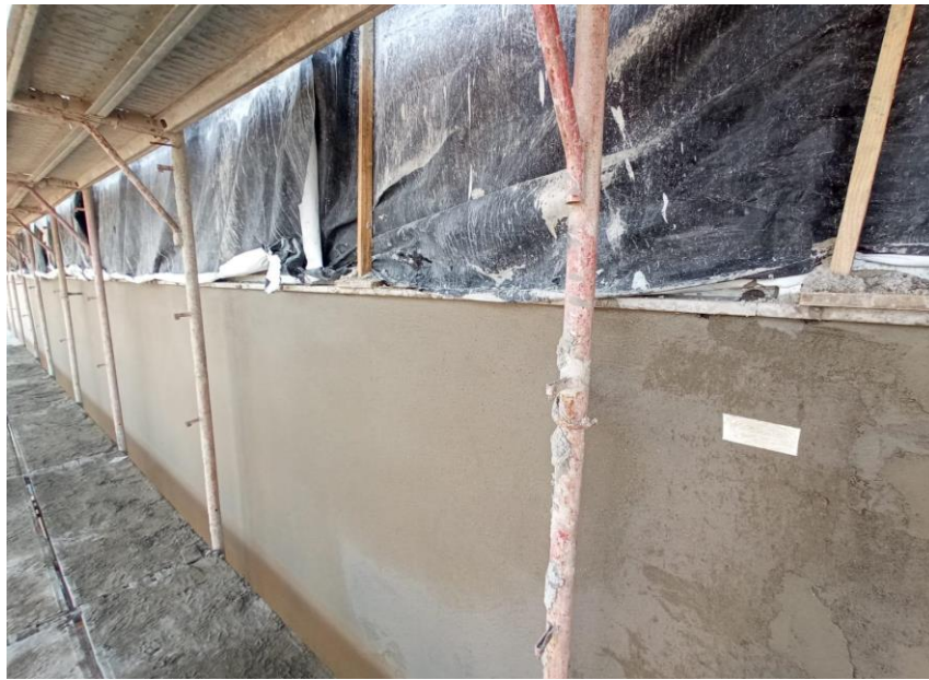
Figura 2 - Execução do revestimento em reboco.
