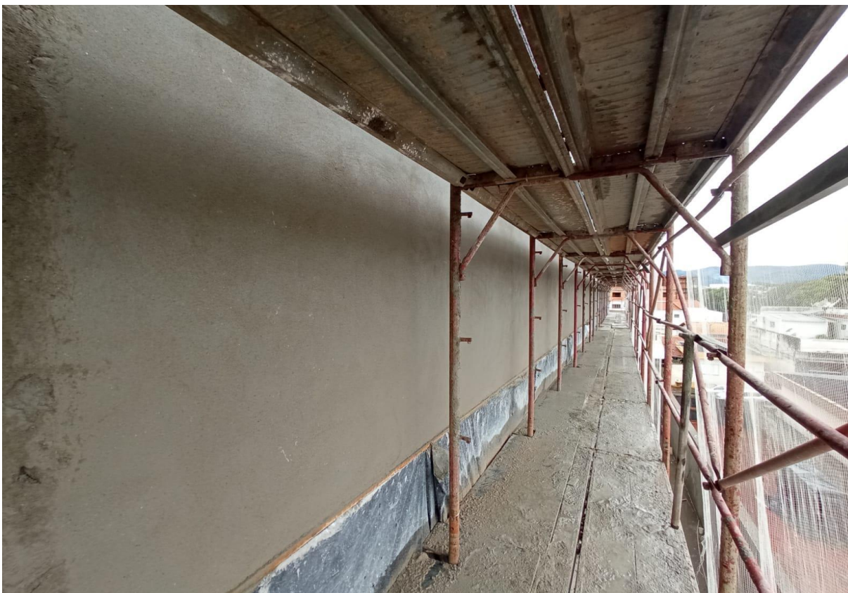
Figura 21 - Finalização do reboco segundo pano.
