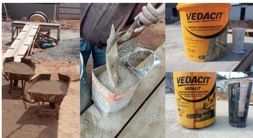
Figura 1 - Realização da mediadas dos materiais para confecção da massa.
