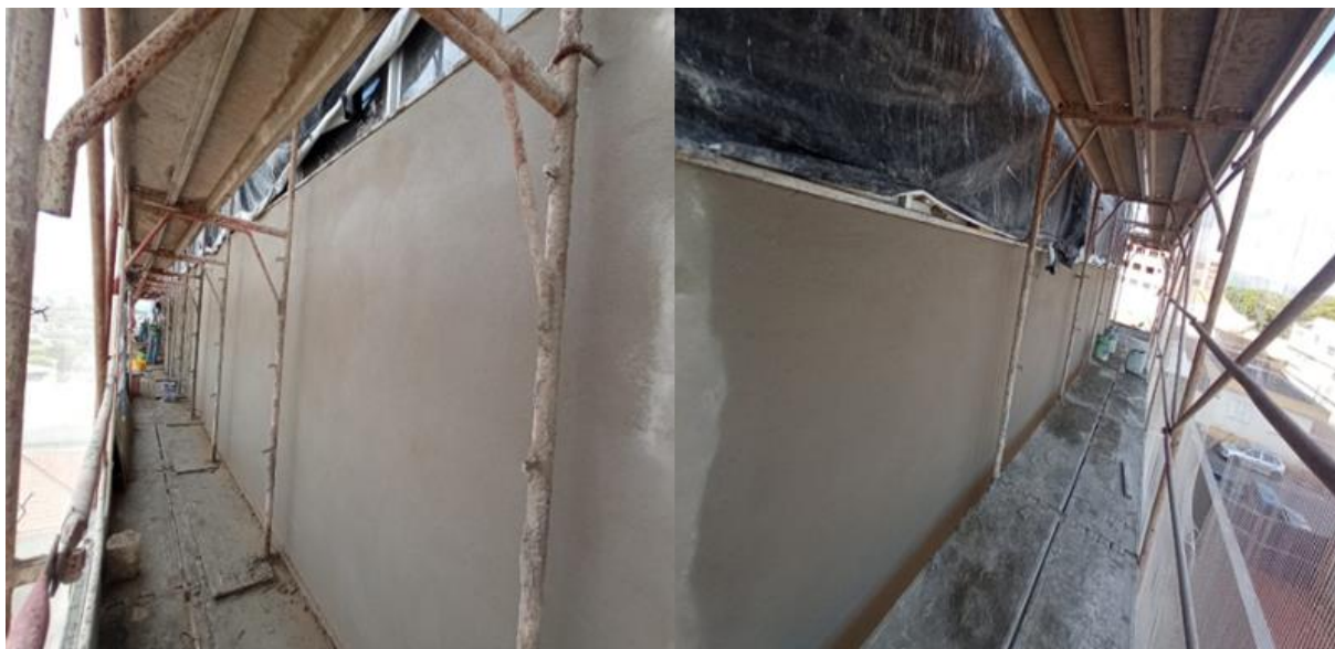
Figura 16 - Execução do revestimento.
