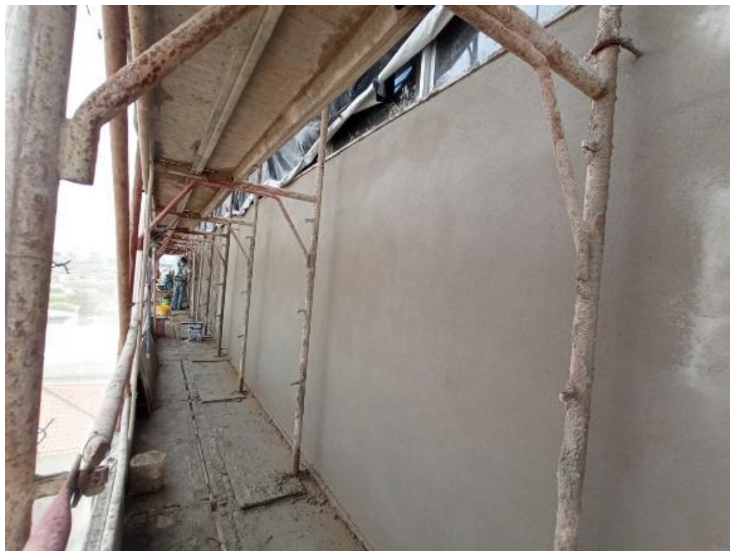
Figura 7 - Execução do acabamento do reboco.
