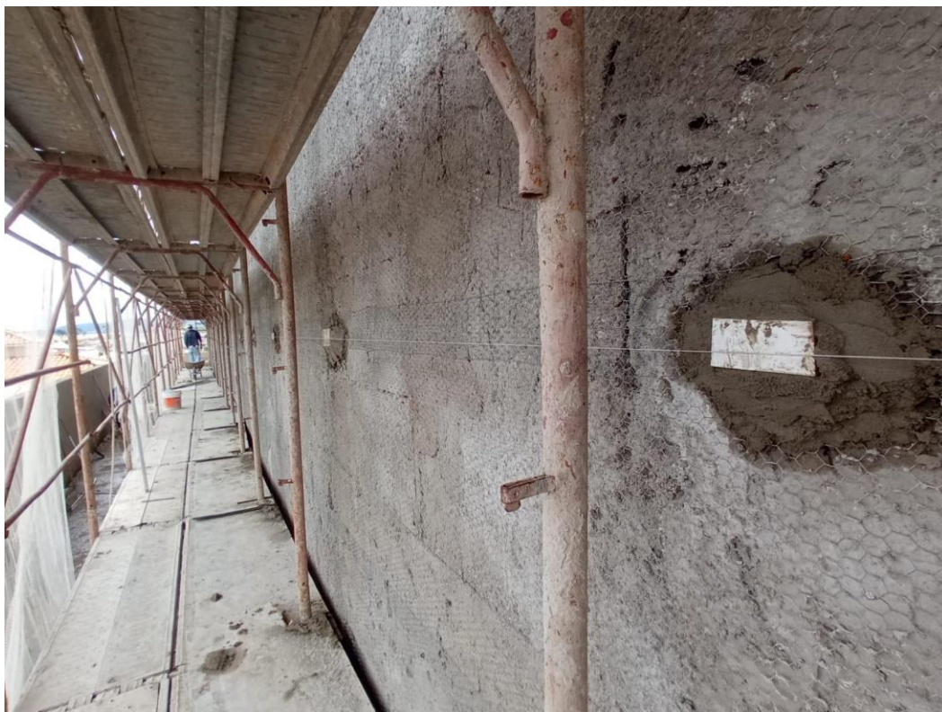
Figura 9 - Execução de talisca para realização do reboco.
