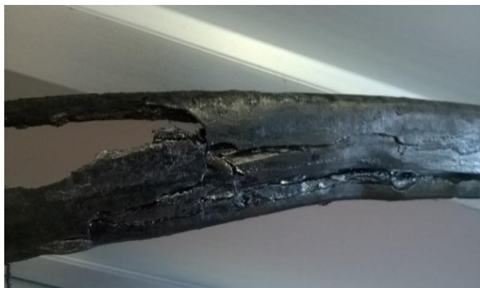
Figura 35 - Fotografia de junta dupla-camisa com falha generalizada após sucessivas tentativas de reaperto dos flanges
