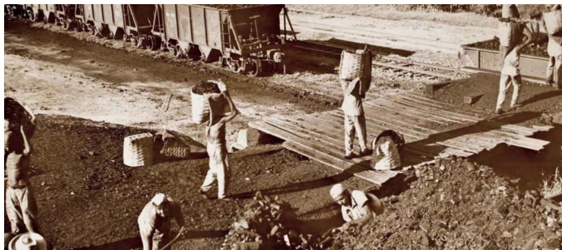
Trabalhadores da Companhia Vale do Rio Doce transportando carvão vegetal, em Itabira, em cestos de vime. Foto: Vale/Divulgação.
