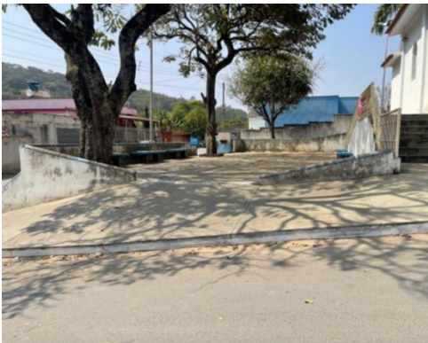
e) Retrato da vegetação, da falta de rampas de acesso e escada
