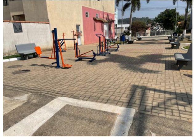
(b) Vista dos equipamentos urbanos, rampa de acesso, piso e banco
