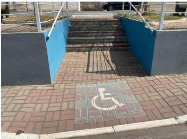
a) Demonstrativo do piso, escada e corrimão
