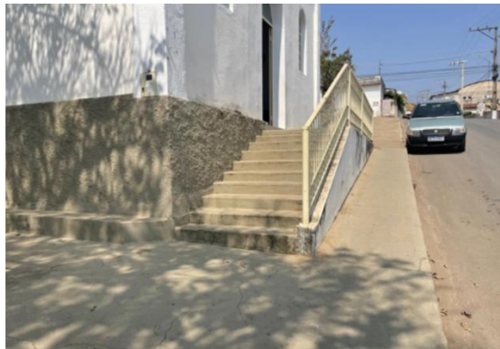
f) Rota de acesso entre pavimentos
