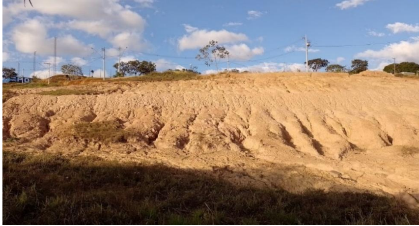
Figura 45 - Talude do Ponto 2
