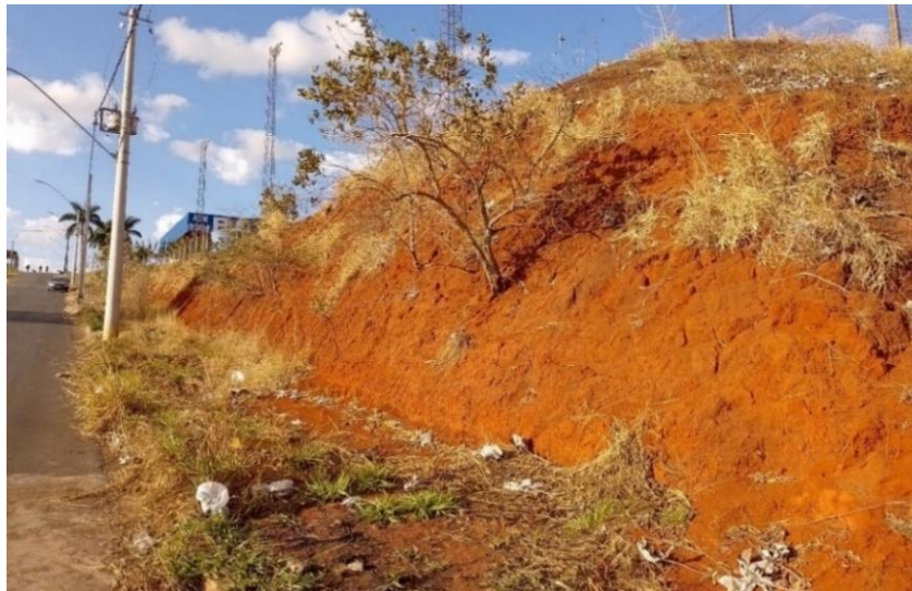
Figura 36 - Talude do Ponto 1
