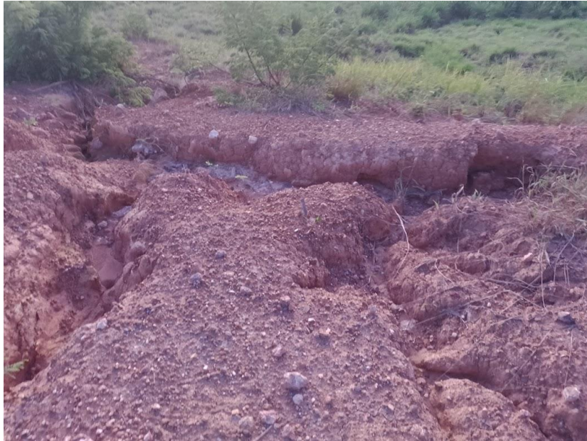
Figura 72 - Sulcos no meio do talude
