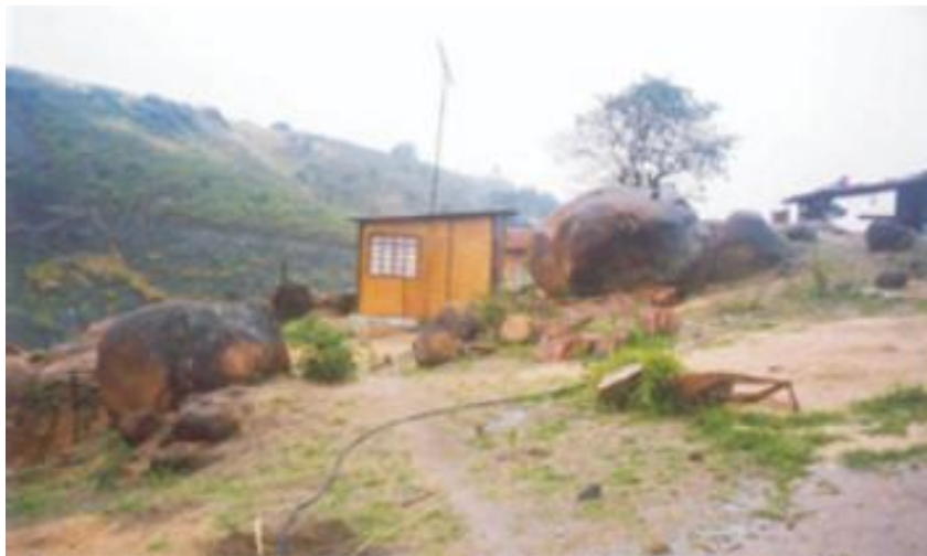
Figura 11 - Residência abaixo de um bloco de rocha
