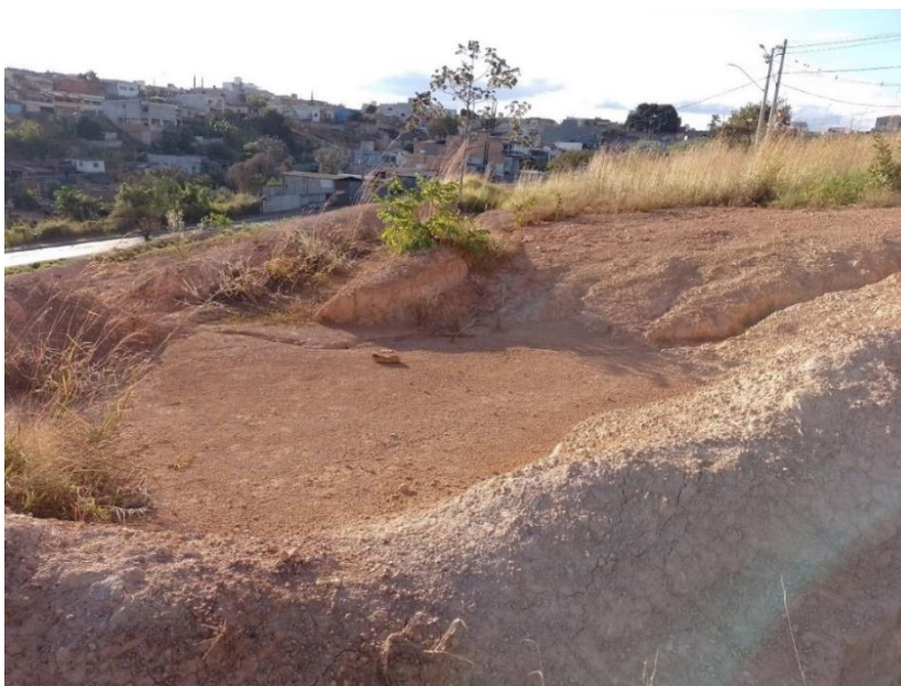
Figura 56 - Local de concentração de água pluvial na superfície
