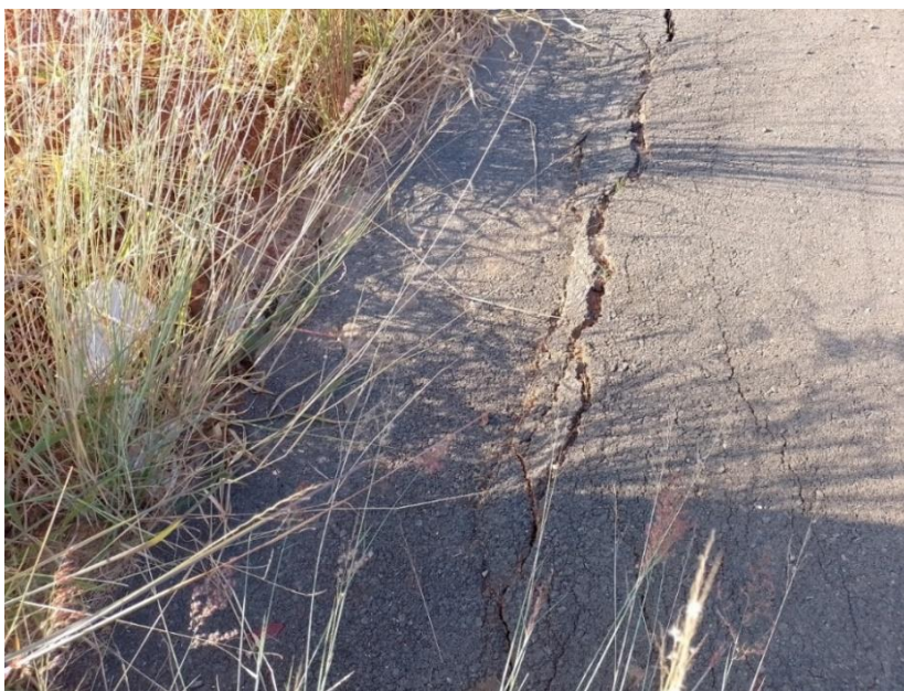
Figura 55 - Rebaixamento do pedaço da rua
