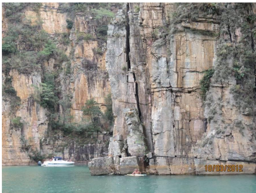
Figura 9 - Bloco de rocha com fissura vertical
