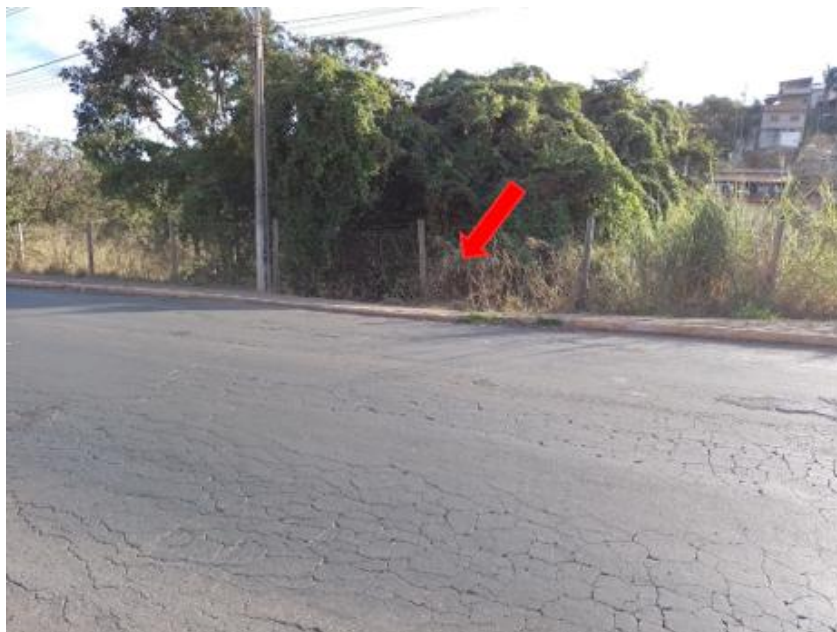
Figura 54 - Rebaixamento do pedaço da rua
