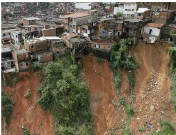
Figura 2 - Movimento de massa em encosta em Campos do Jordão - SP
