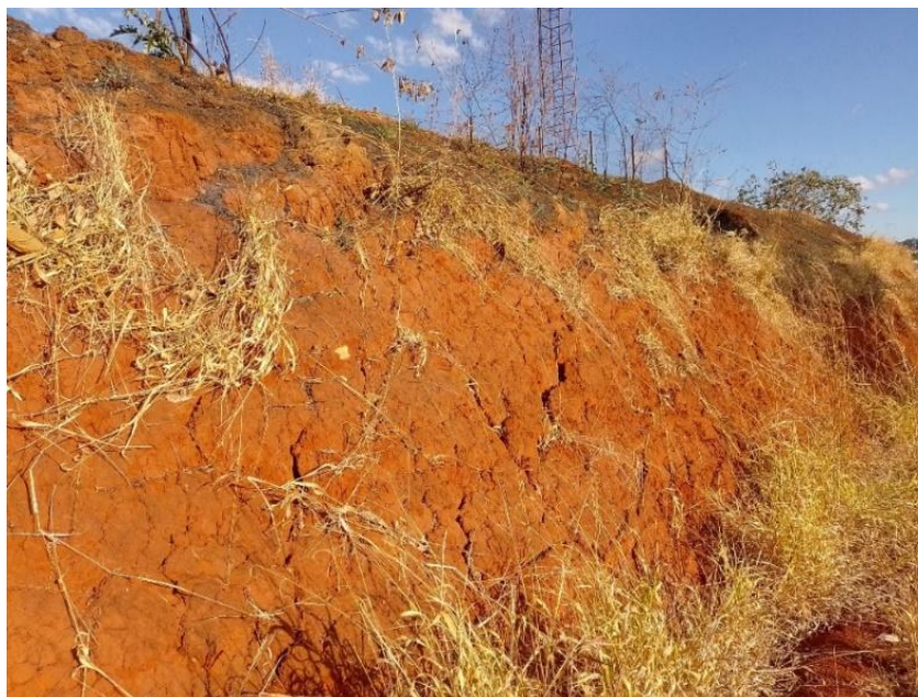
Figura 39 - Solo apresentando trincas na inclinação forte
