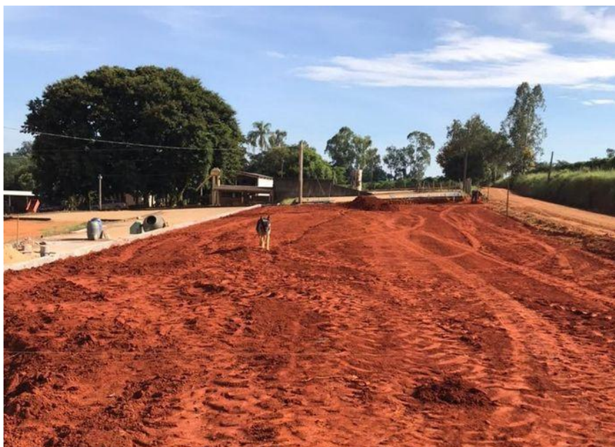
Figura 21 — Terraplenagem e muro de contenção
