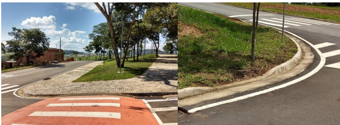
Figura 27 - Passagens de pedestres elevadas e guias de meio rebaixadas.
