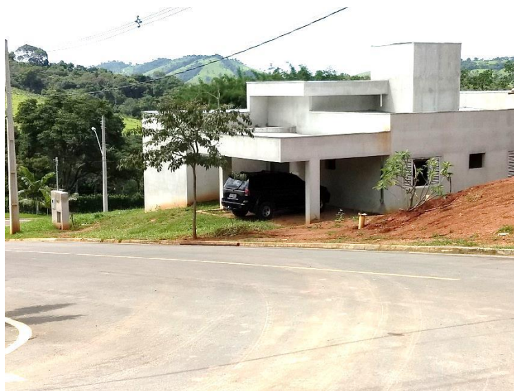
Figura 31 - Residência habitada sem local adequado para acondicionamento do lixo.
