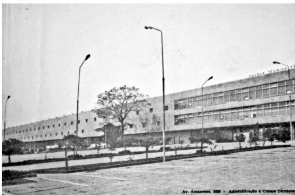
Figura 7 - Fachada principal e estacionamento
