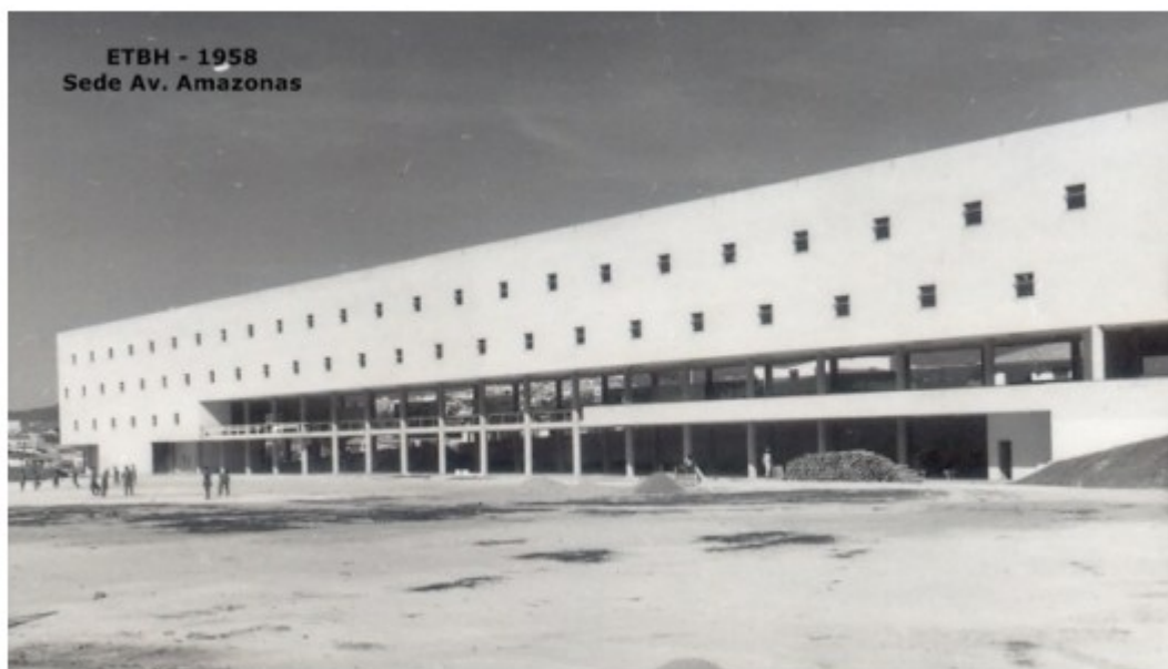
Figura 5 – Construção, em fase de acabamento, da nova sede da ETBH
