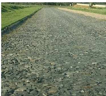
Figura 6: pista com calçamento
