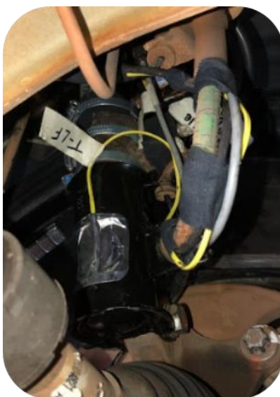
Figura 20: Fixação de termopar
