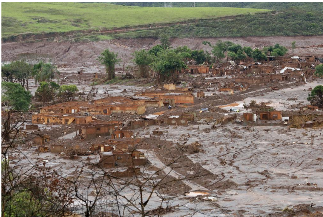
Figura 1 - Vista do desastre do rompimento da barragem do Fundão de Mariana - MG.
