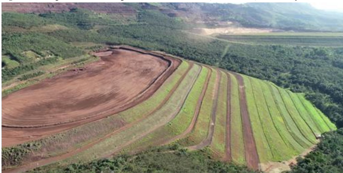
Figura 2 - Barragem nível 3 de emergência da Mina Serra Azul (ArcelorMittal) em Itatiaiuçu, MG.
