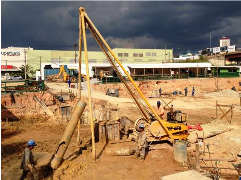
Figura 16 – Execução da estaca Strauss
