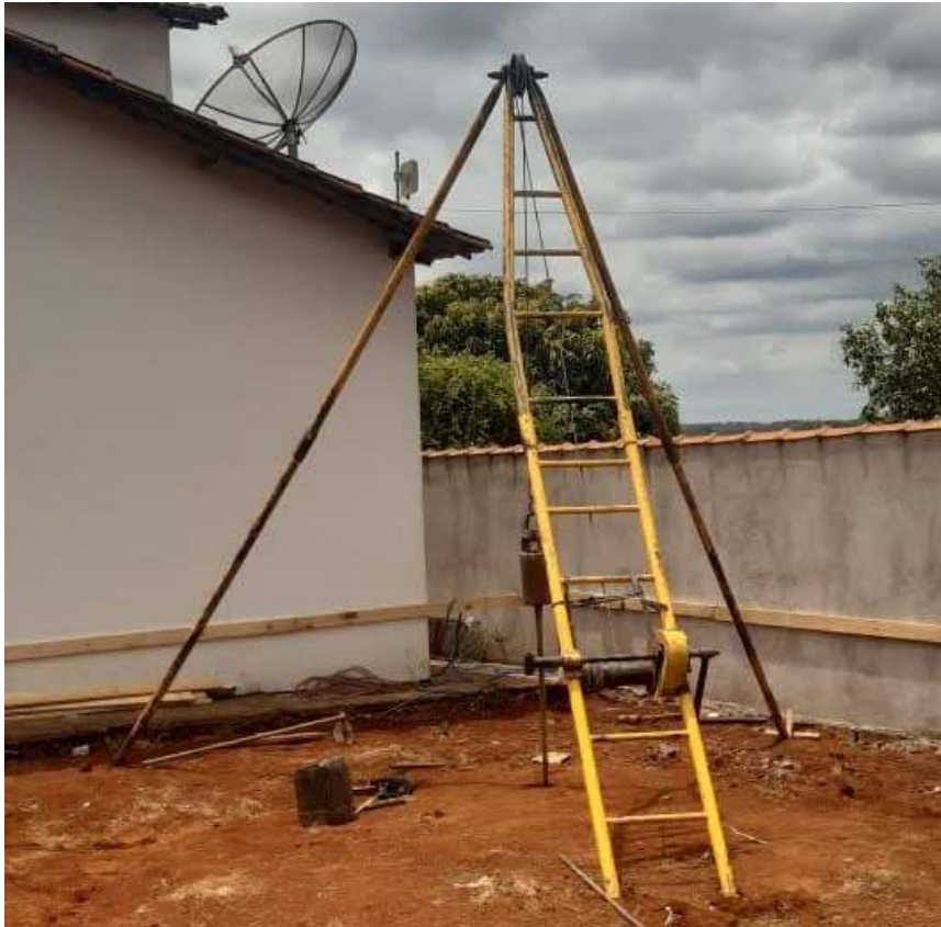
Figura 33 – Equipamento de sondagem SPT manual
