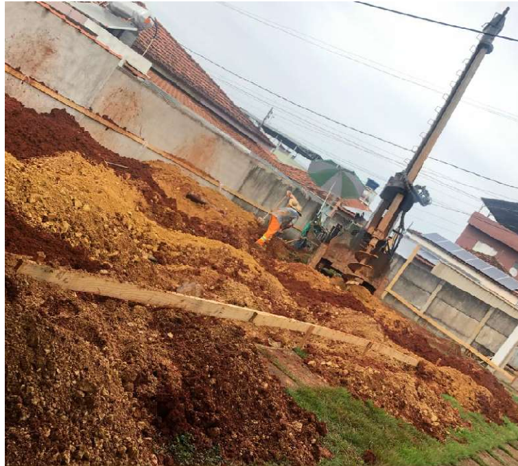
Figura 39 – Execução estaca escavada mecanicamente com trado helicoidal
