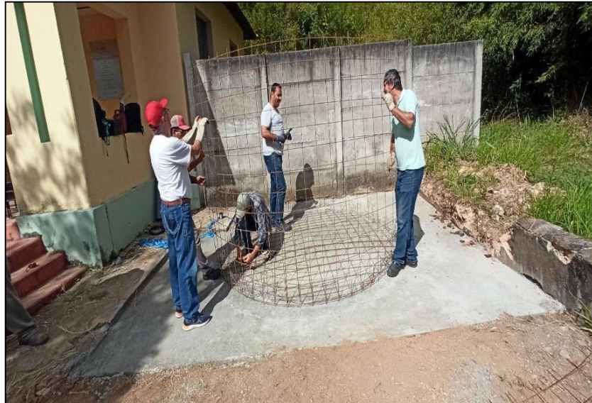
Figura 10 – Fixação da parede 1
