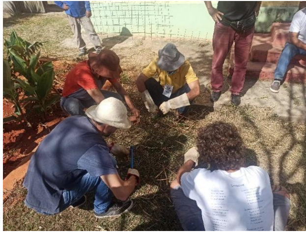
Figura 2 e 3 - Atividade prática - montagem da estrutura da cisterna
