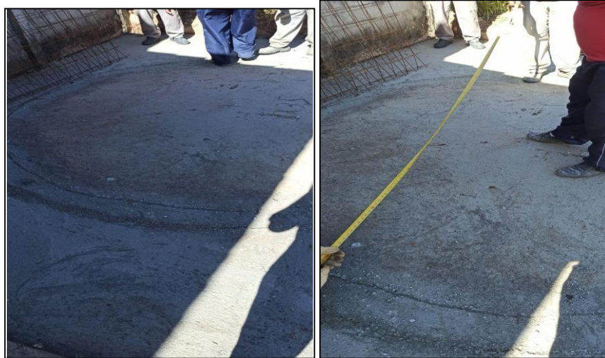
Figura 6 e 7 – Preparação do contrapiso
