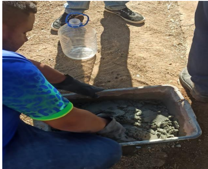
Figura 14 – Preparo da argamassa
