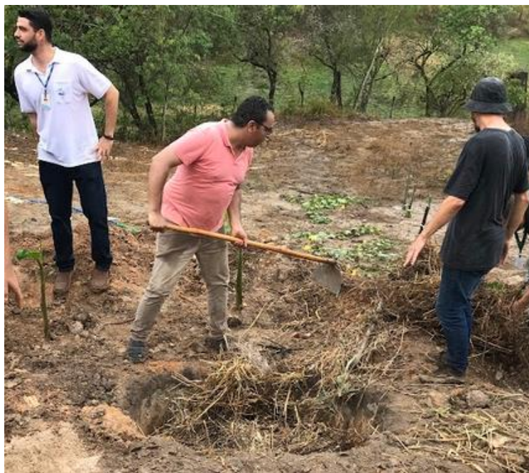
Figura 8 – Escavação e preenchimento da vala
