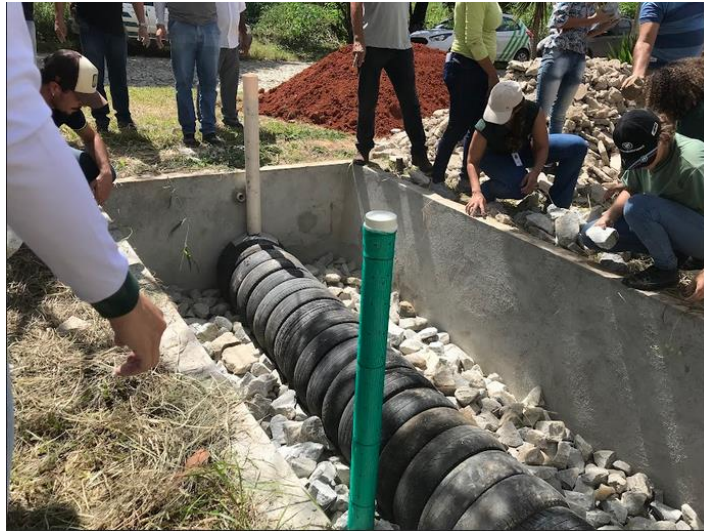
Figura 7 – Instalação da câmara interna e dos substratos filtrantes
