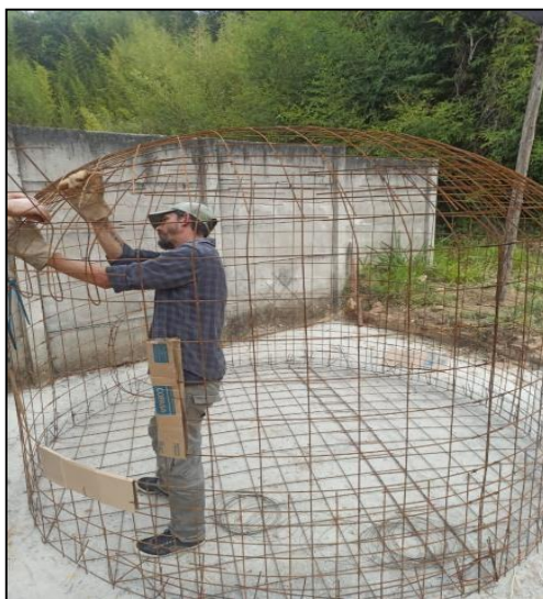
Figura 12 – Travamento do teto da estrutura
