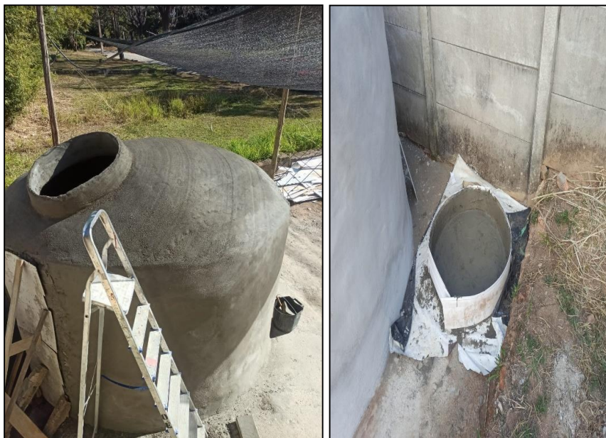
Figura 17 e 18 – Abertura e tampa da estrutura
