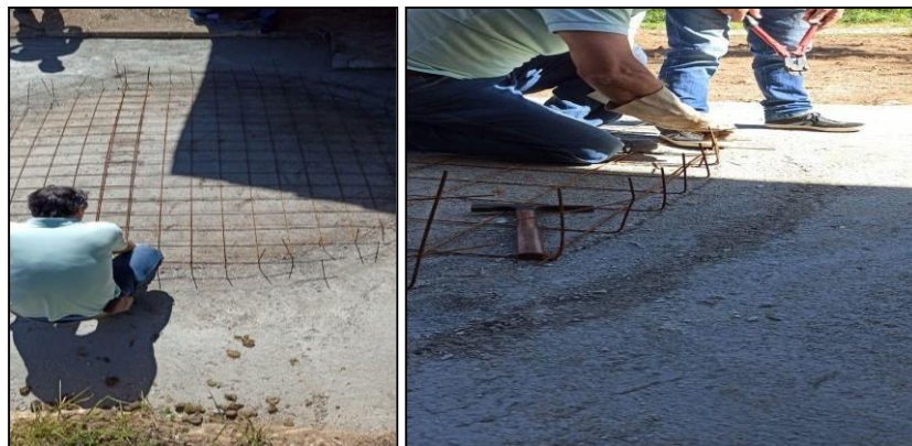
Figura 8 e 9 – Malha de ferro e dobras do piso para fixação da parede
