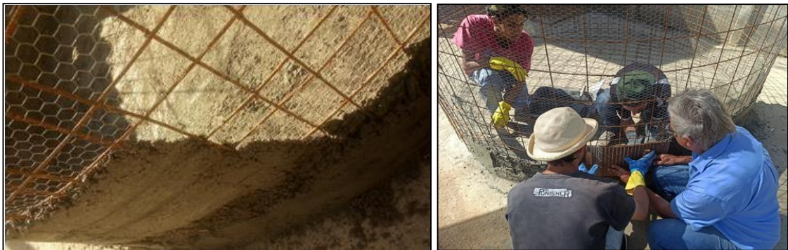
Figura 15 e 16 – Aplicação da argamassa na parede da estrutura
