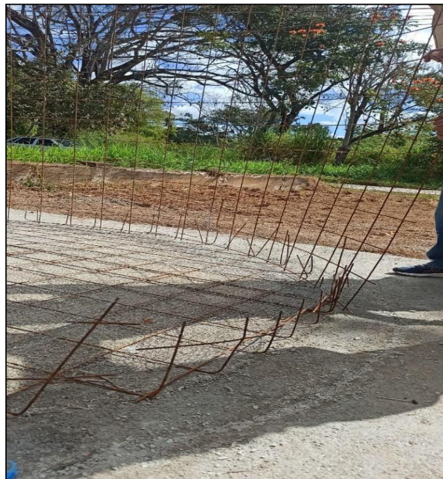
Figura 11 – Fixação da parede 2
