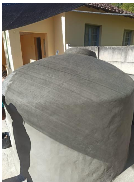
Figura 19 – Reservatório em processo de cura
