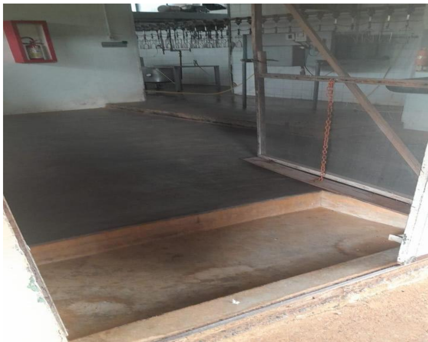
Figura 1: Entrada do abatedouro didático do IFMG – Campus Bambuí
