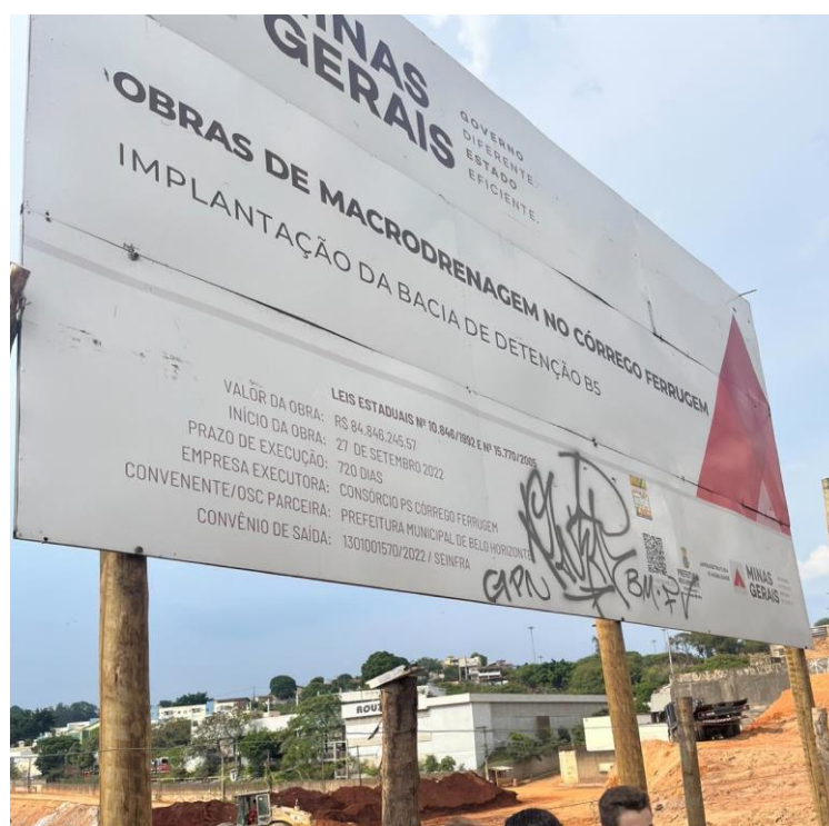
Figura 2 – Obra para construção da Bacia de Detenção no Córrego Ferrugem
