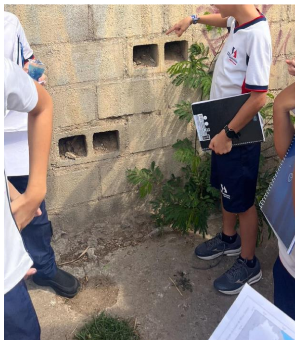
Figura 33 - Ponto de escoamento de água
