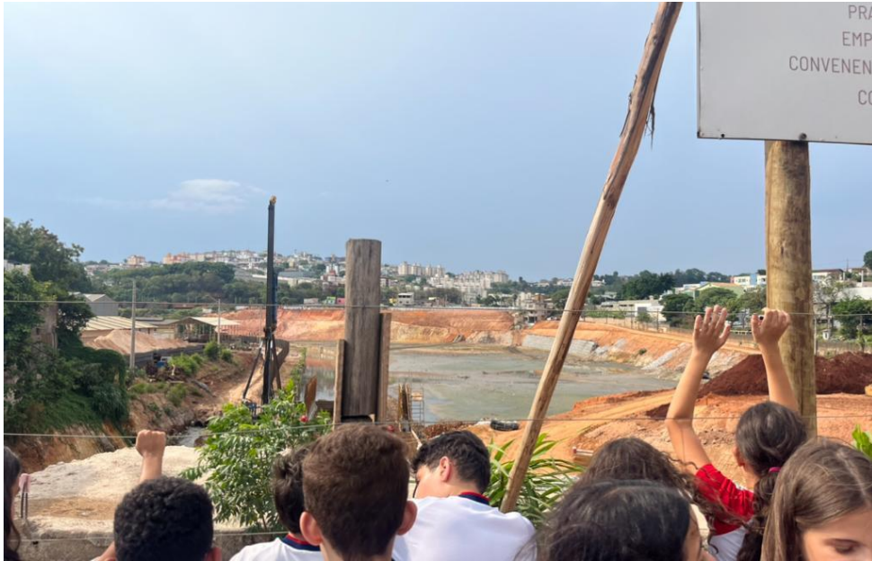
Figura 34 - Bacia de retenção do córrego Ferrugem
