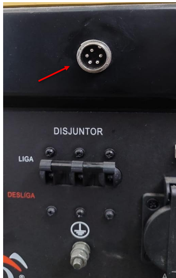
Figura 22 - Conector instalado no motogerador.
