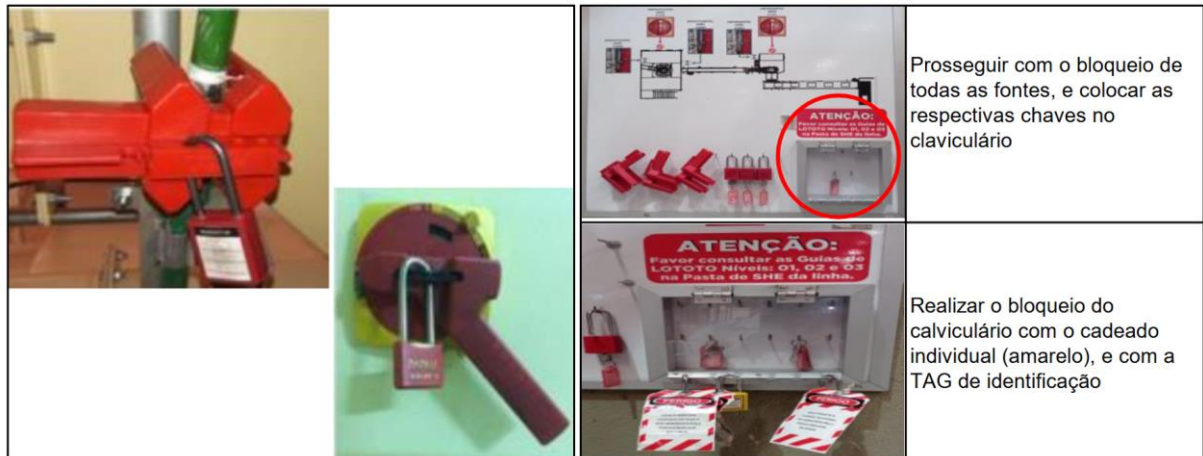
Figura 31 - Etapa de bloqueio do procedimento de LOTOTO
