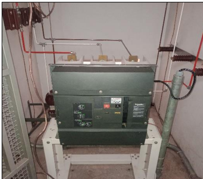
Figura 14 - Disjuntor Geral
