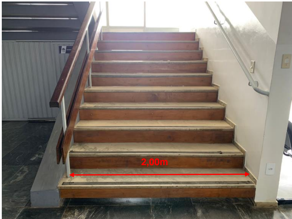
Figura 35 - Escada primeiro pavimento.
