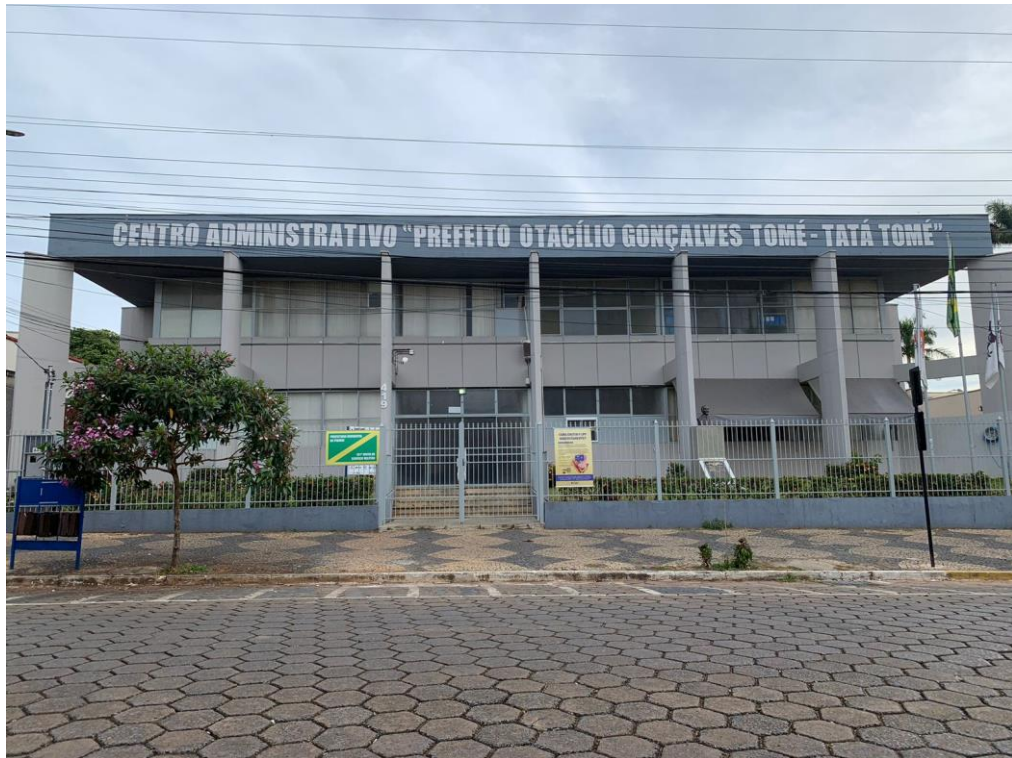
Figura 22 - Edificação do estudo.
