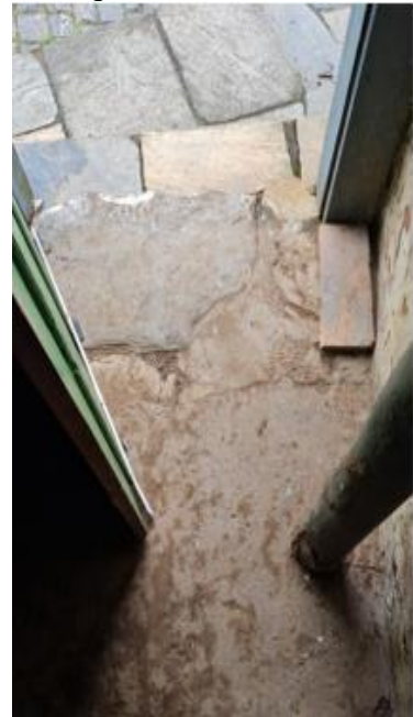
Imagem 11: Piso de entrada, piso em cimento liso e pedra quartzito, 02/2023
