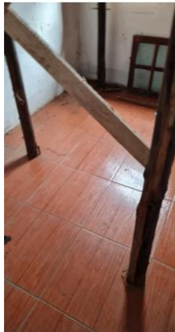
Imagem 25: Quarto, piso cerâmico sobre laje construído em cima do antigo do piso de madeira
