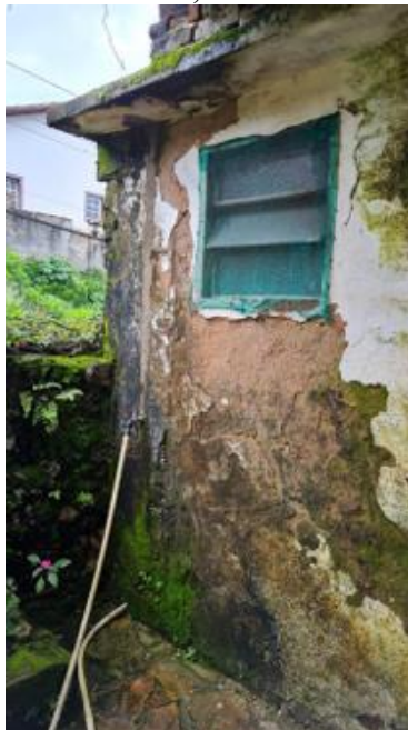
Imagem 29: Esquadrias do imóvel, 02/2023
