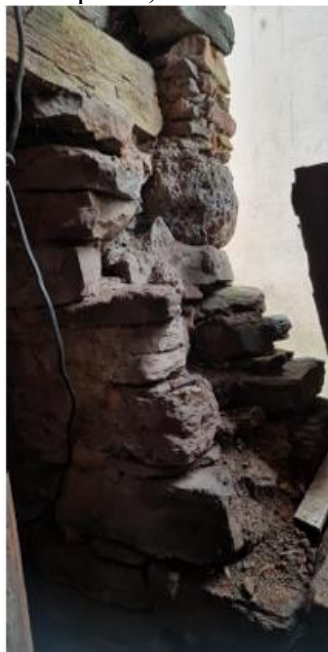
Imagem 7: Alvenaria de de pedra, 02/2023
