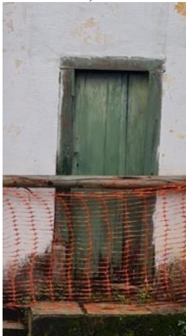
Imagem 30: Esquadrias do imóvel, 02/2023
