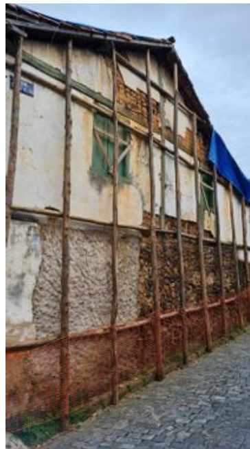
Imagem 4: Fachada lateral escoradas, 02/2023
