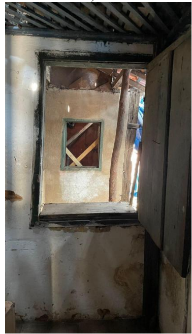
Imagem 31: Esquadrias do imóvel, 02/2023
