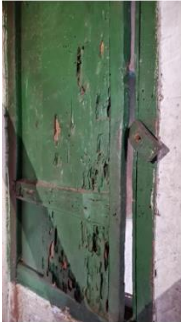
Imagem 26: Esquadrias do imóvel, 02/2023
