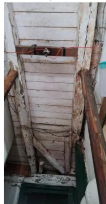
Imagem 8: Forro de madeira do hall, 02/2023
