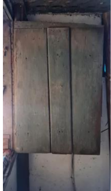
Imagem 28: Esquadrias do imóvel, 02/2023
