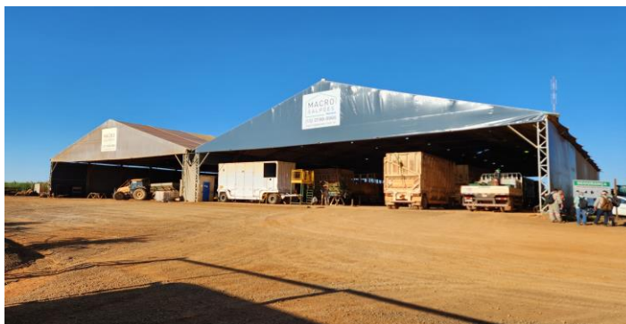
Figura 4: Entrada da oficina.
