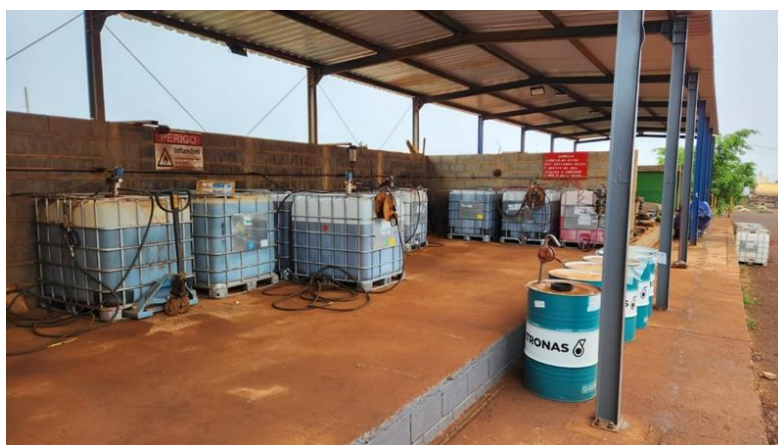
Figura 20: Depósito de fluidos.
